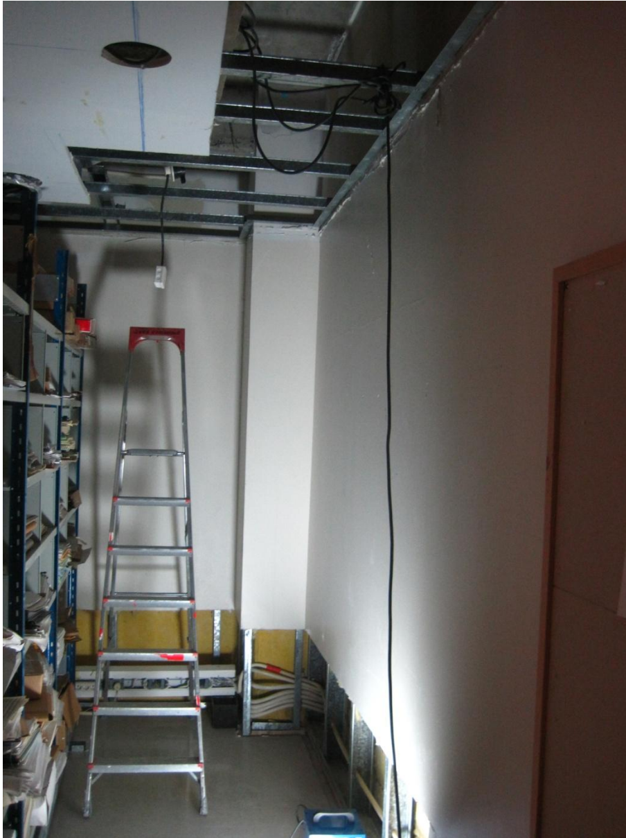
KUVA 4. Alakatto ja seinät avattuina (Kuva: Timo Mäkinen 2011)
