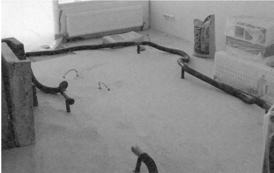
KUVA 1. Uivan betonilattian alla olevan villan kuivaus (Lumme & Merikallio 1997, 8)
