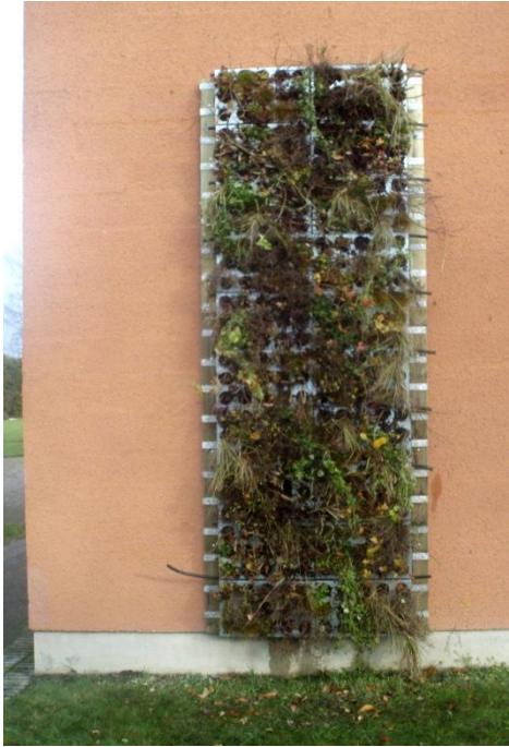
Kuva 13 Valmiiksi asennettu seinä, jonka sivuilla erottuvat tihkuletkujen päät ja rungon osat, jotka peitetään keväällä.
