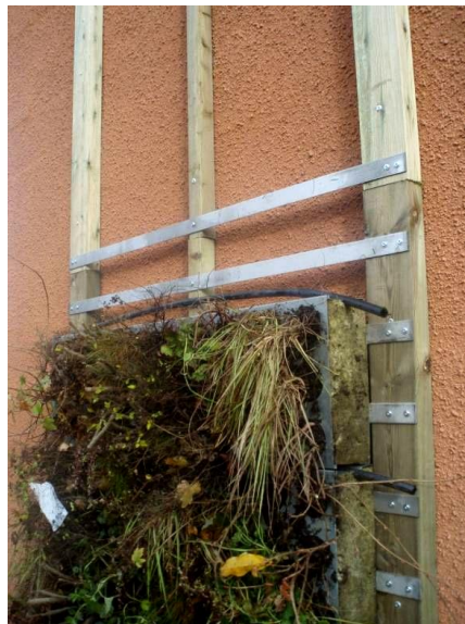
Kuva 12 Seinän asennus on kesken ja tihkuletku on laitettu paikalleen ennen seuraavaa moduulikerrosta. Kuvassa näkyy hyvin myös rungon rakenne.
