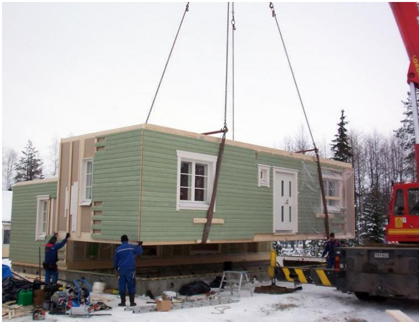
Kuva 4. Tilaelementin asennus. [8.]
