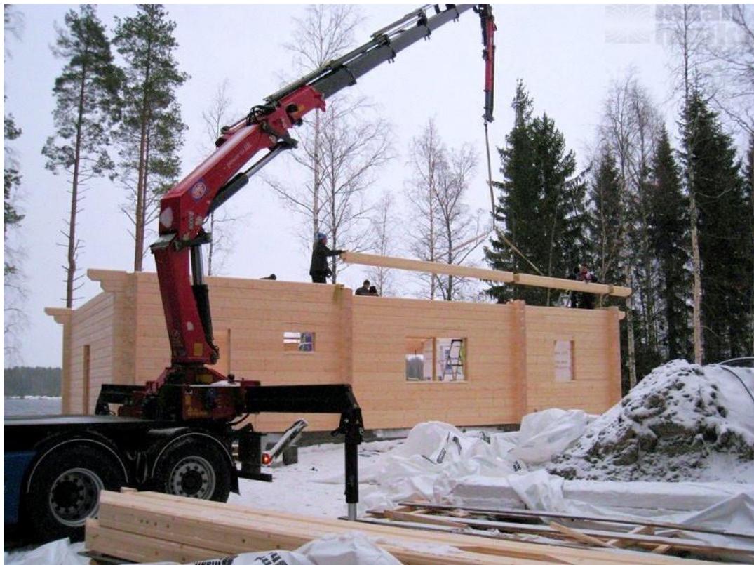
Kuva 2. Hirsirungon pystytys. [6.]
