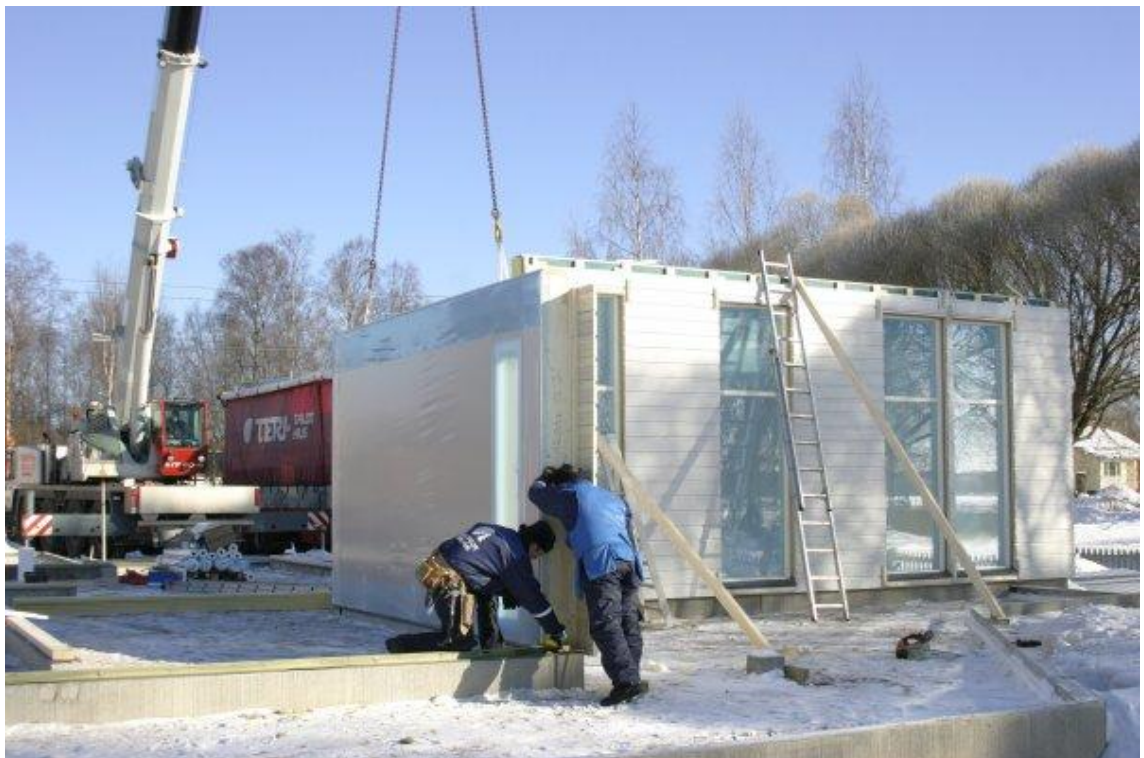
Kuva 3. Suurelementin asennus. [7.]
