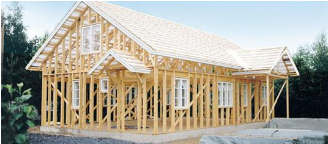
Kuva 1. Pre-cut-järjestelmällä rakennettu runko. [5]
