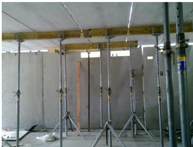
Kuva 30. Kuorilaattojen työnaikainen tuenta
