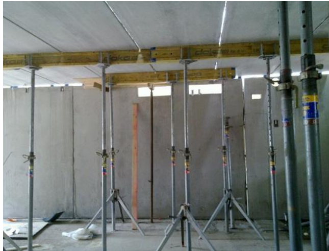
Kuva 20. Kuorilaataston työnaikainen tuenta
