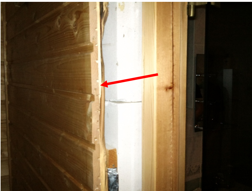
KUVA 20. Pesuhuoneen ja saunan välinen seinä avattuna Valokuva Pasi Kanerva 2010
