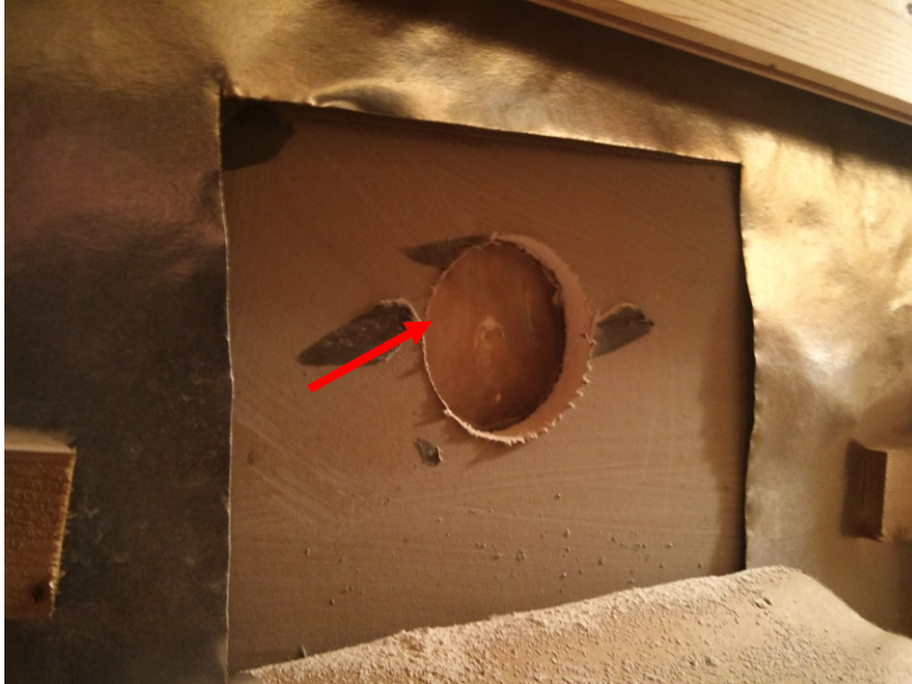
KUVA 21. Tarkastusaukosta nähdään höyrynsulkumuovi saunan ulkoseinässä. Valokuva Pasi Kanerva 2010
