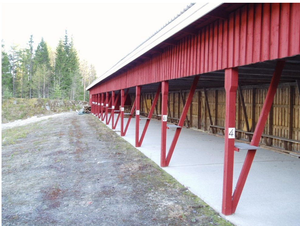
KUVA 2.34 Katosrakenne. Rakenteen suunnittelussa ei ole otettu äänen vaimennusta huomioon, koska sillä ei ole katsottu olevan merkitystä radan teko-aikaan. Kuva; Tommi Turunen 2011.
