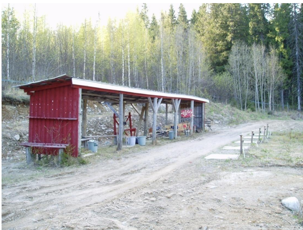
KUVA 2.32 Olympiatrap-katos. Katos on huonossa kunnossa, eikä siitä harasteta ammuntaa sen väärän sijainnin takia. Kuva; Tommi Turunen 2011.
