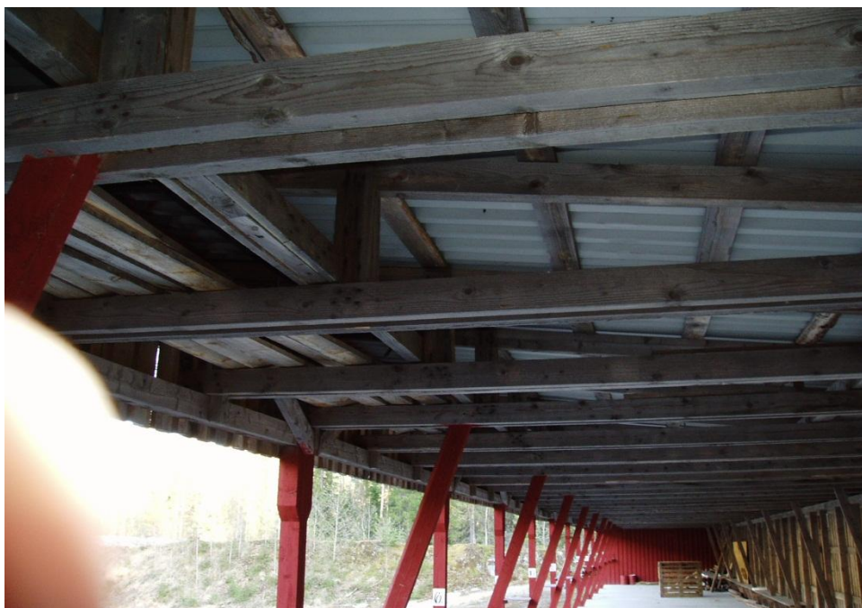
KUVA 2.31 Kattotuolit. Kattoa on jouduttu tukemaan talveksi, koska se ei kestä lumikuormia ja painumat pyrkivät kasvamaan liian suuriksi. Kuva; Tommi Turunen 2011.
