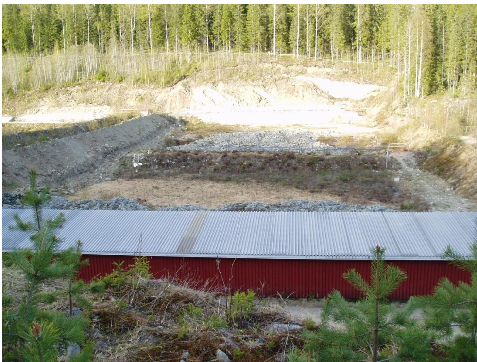
KUVA 2.33 Luodikkorata. Radan suojavallit ovat painuneet, eikä 50 m:n ammuntapaikkaa ole tasattu oikeaan korkoon. Kuva; Tommi Turunen 2011.
