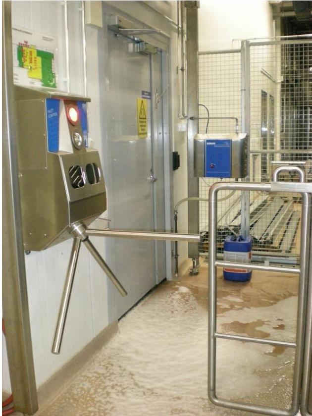
Kuva 4. Kylmävaraston ja pakkausosaston välinen hygieniasulku, jonka käsiendesinfointilaitteeseen on yhdistetty portti estämään kulku korkeamman hygienian suuntaan ilman käsien desinfiointia.
