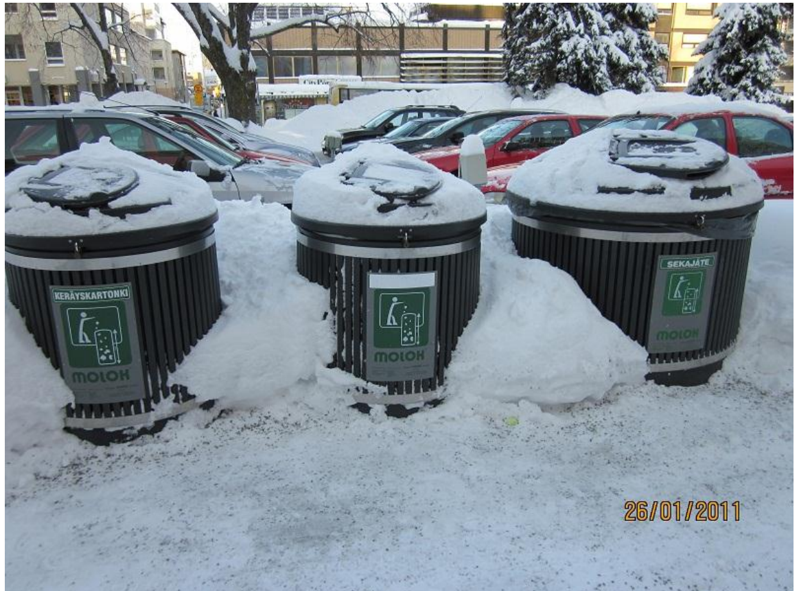
KUVA 3. Molok-syväkeräysjärjestelmä kiinteistöllä. Kuva Matias Enäsuo.
