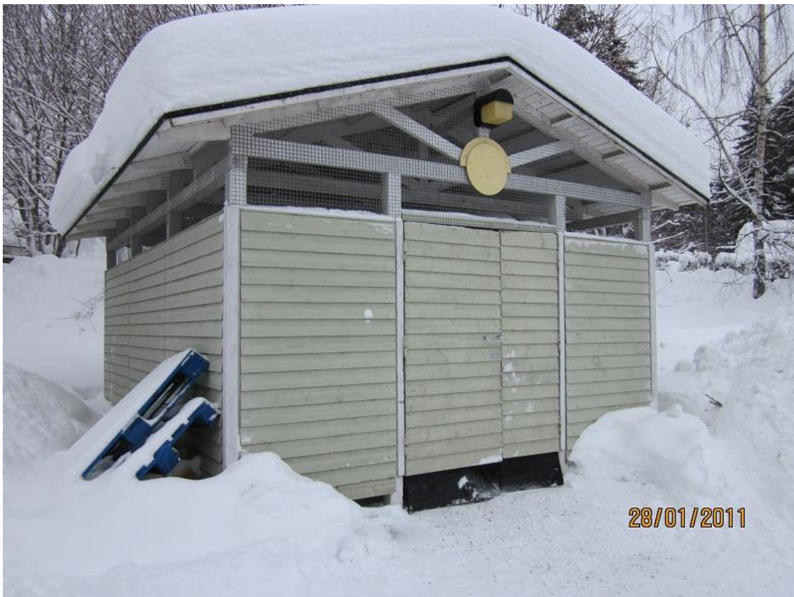
KUVA 4. Jätekatos kiinteistöllä. Kuva Matias Enäsuo.
