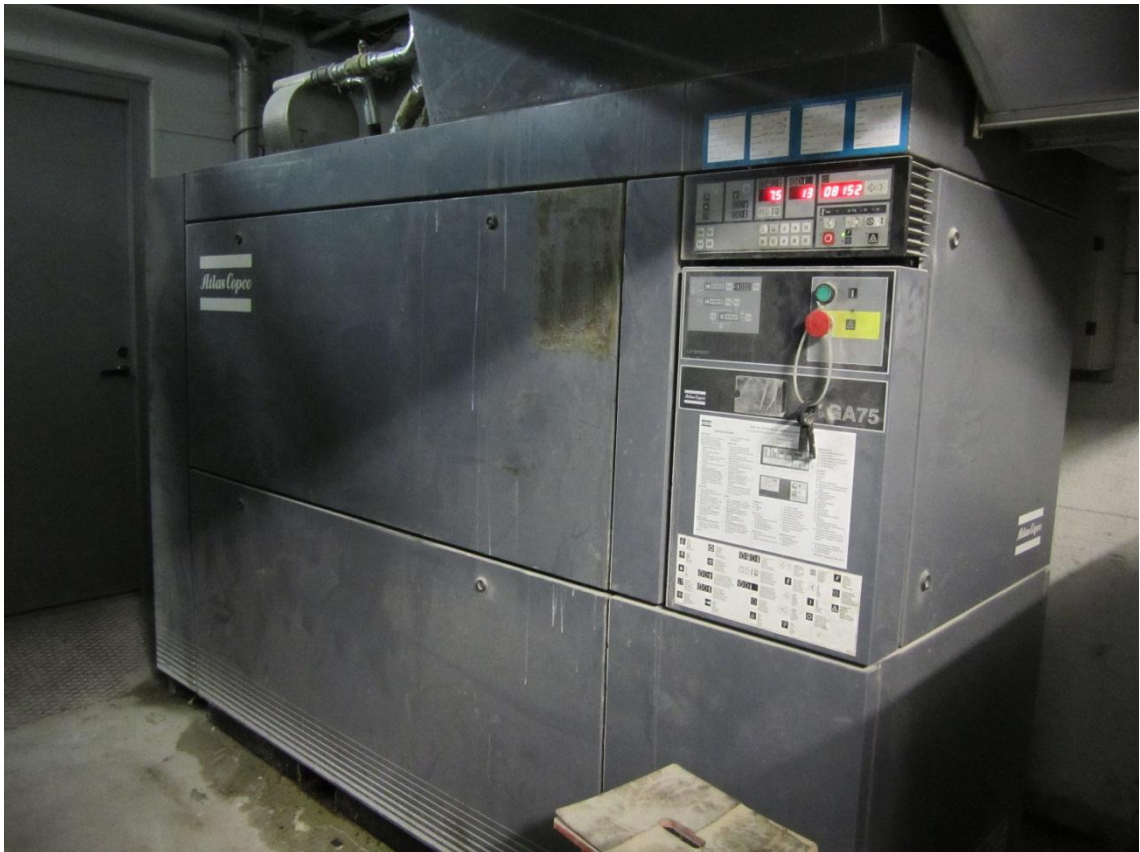
Kuva 7. Atlas Copcon kompressori GA 75.
