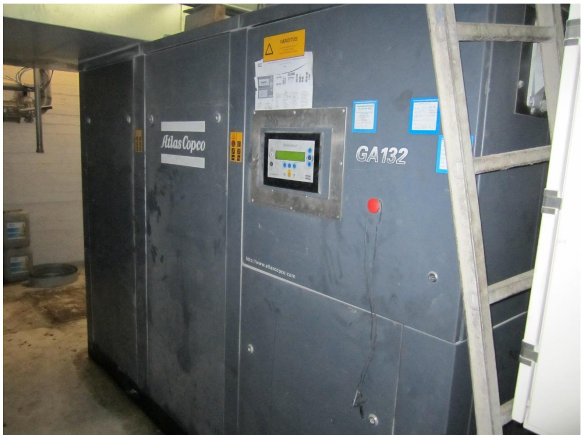
Kuva 6. Öljysuihkuperiaatteella toimiva Atlas Copcon GA 132 -ruuvikompressori.
