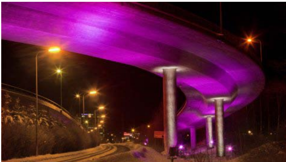
Kuva 6. Jyväskylän Vaasankadun risteyssilta
