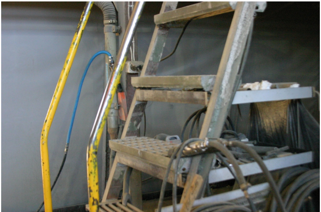
Kuva 3.7. Viimeistelypään pohjoispuolen pukkien portaat
