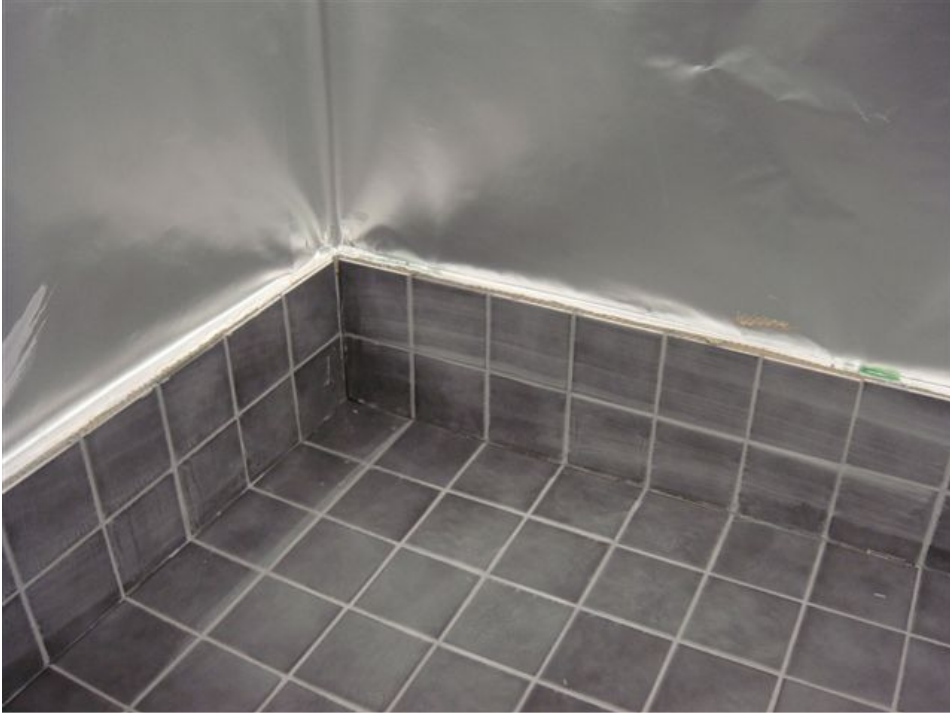
Kuva 35. Laatan nosto seinälle[2].
