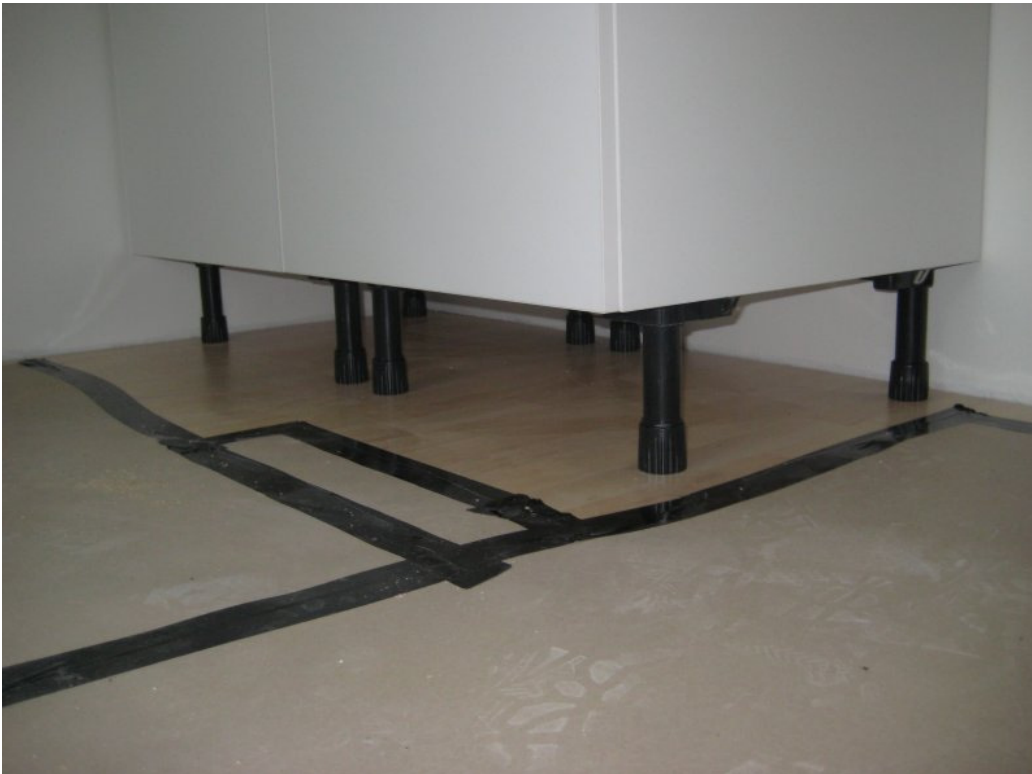
Kuva 28. Kiintokalusteiden alle asennetaan laminaatti tai parketti[2].
