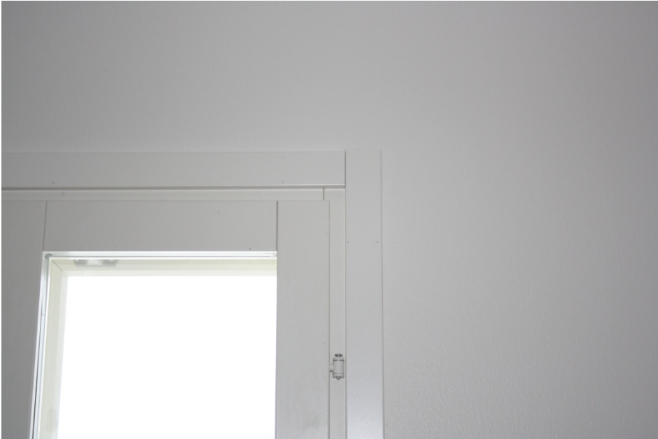
Kuva 4. Ikkunan ja oven peitelista[2].
