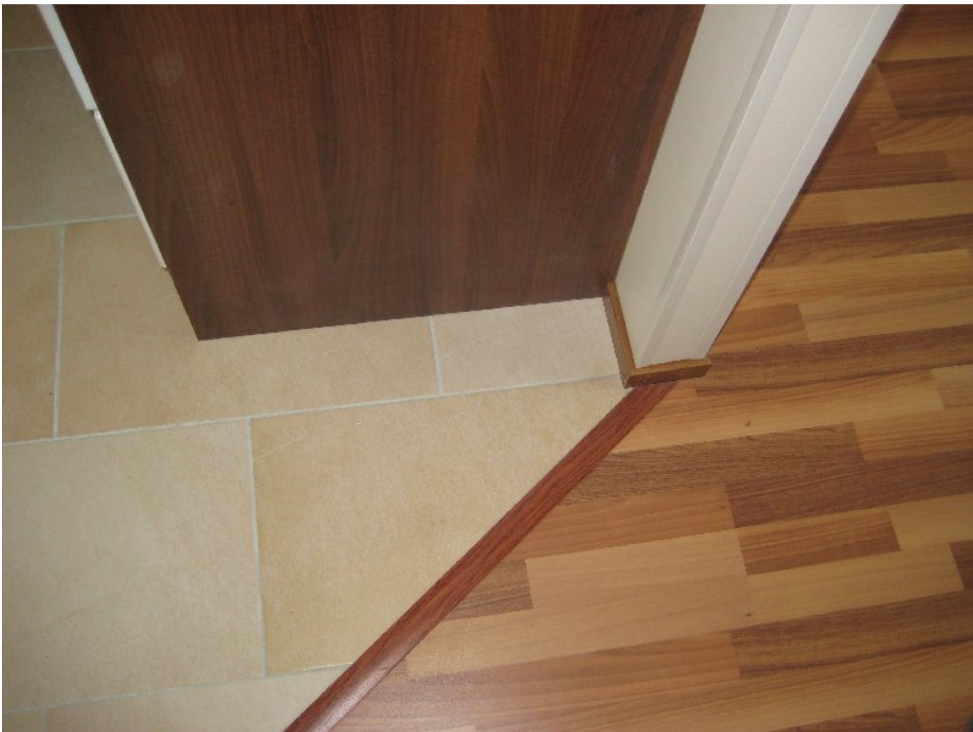
Kuva 15. Keittiön ja olohuoneen lattiamateriaalin liitos[2].
