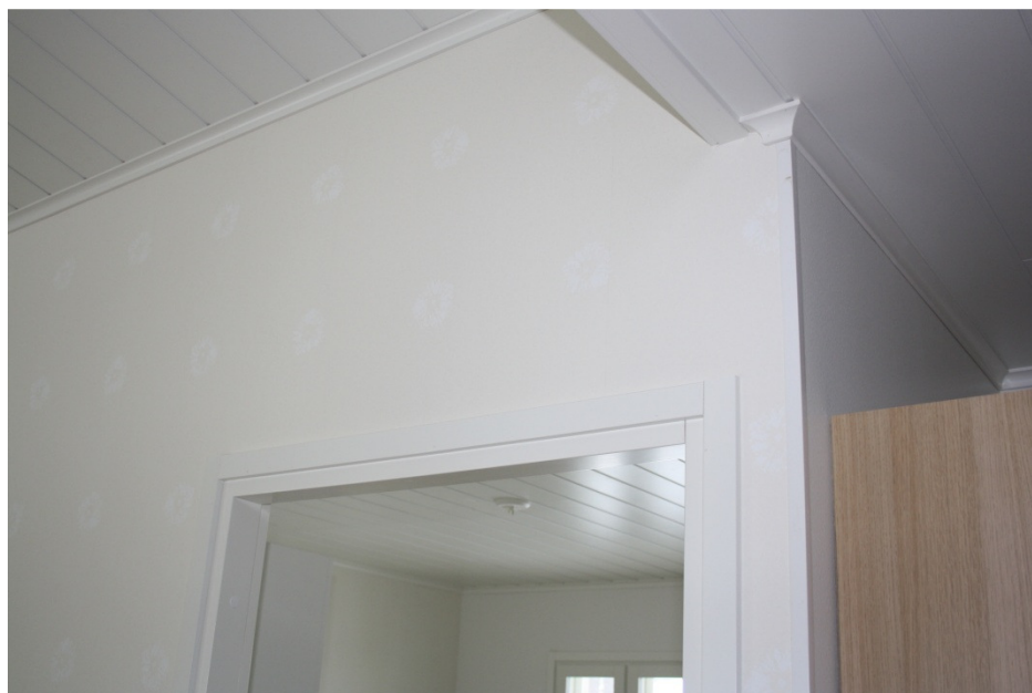
Kuva 7 Nurkka- ja kattolista[2].
