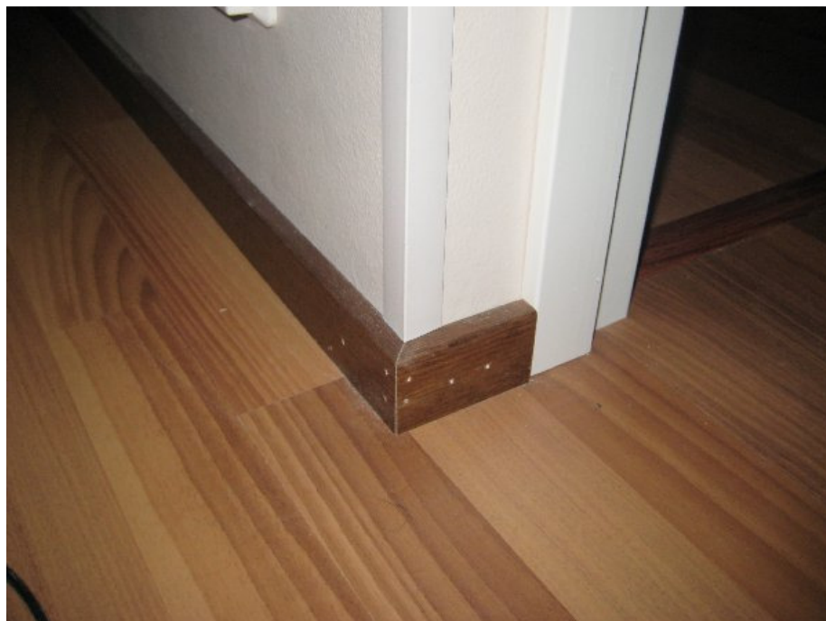
Kuva 6. Ulkonurkkan jiiiriliitos[2].
