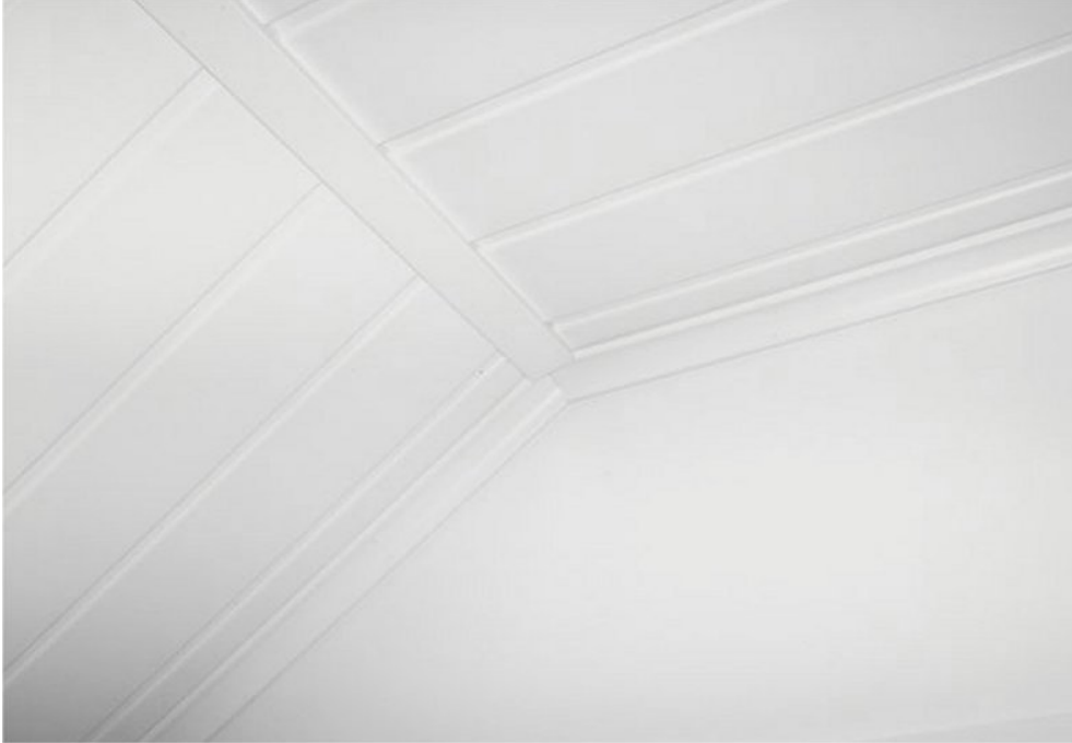
Kuva 38. Sisäkaton taitteen suoralista[2].
