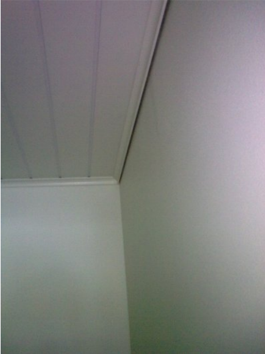
Kuva 26 Tuuletusrako[2].
