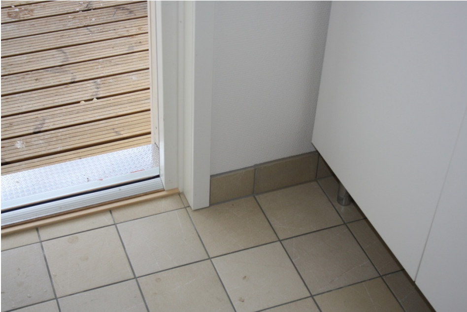
Kuva 20. Lattialaatan nosto seinälle[2].
