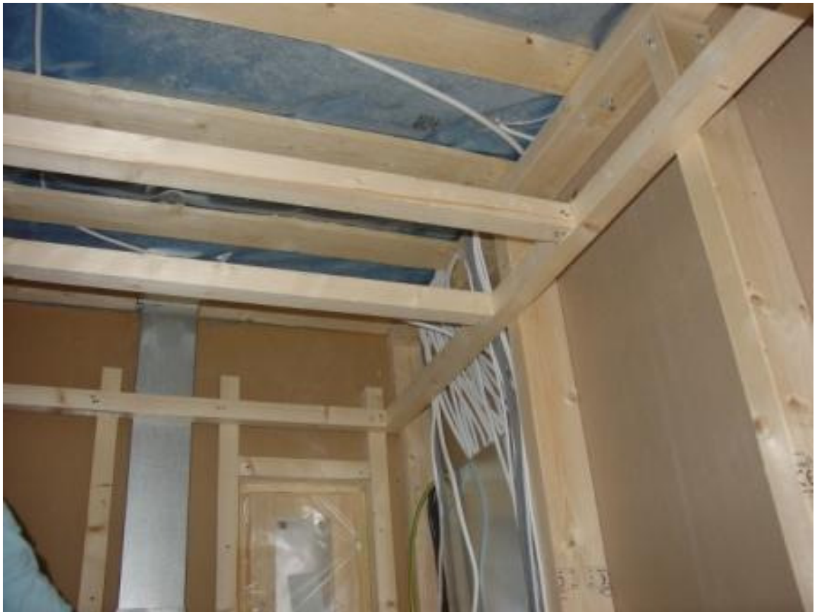
Kuva 7. Seinä- ja kattokoolaukset.[2]
