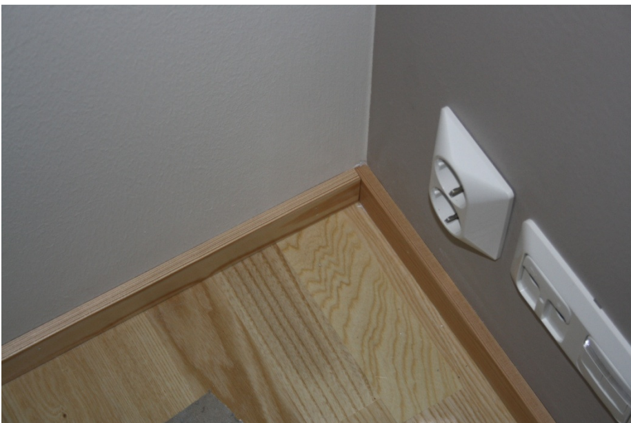
Kuva 5. Sisänurkka tehty päittäisliitoksella[2].
