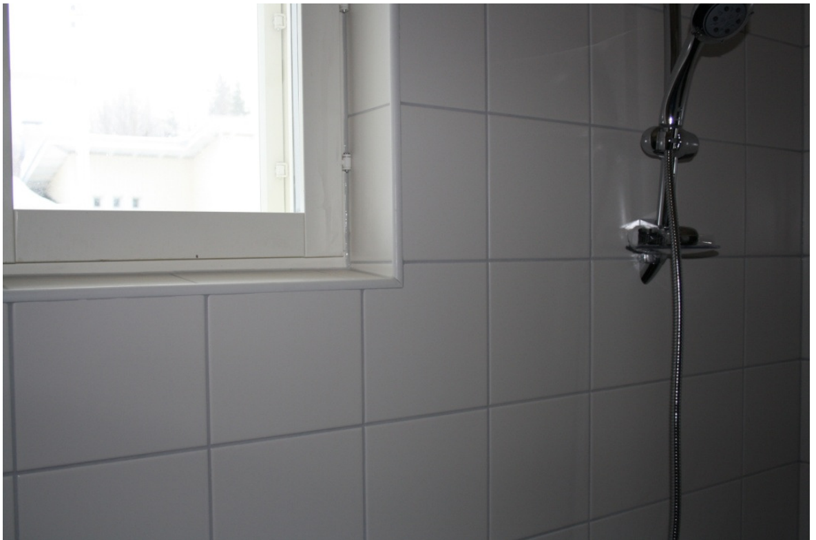
Kuva 8. Laatoitettu ikkunasmyygi [2].
