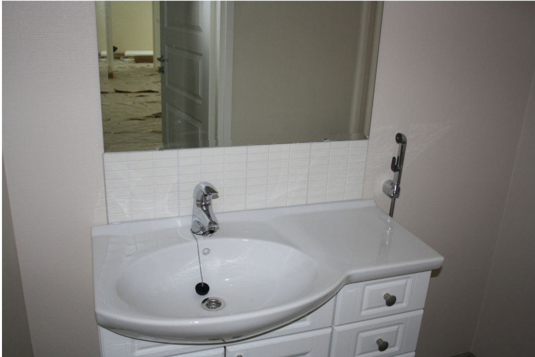
Kuva 19. WC altaan laatoitus[2].
