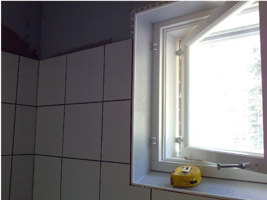
Kuva 32. PH:n ikkuna laattalista[2].
