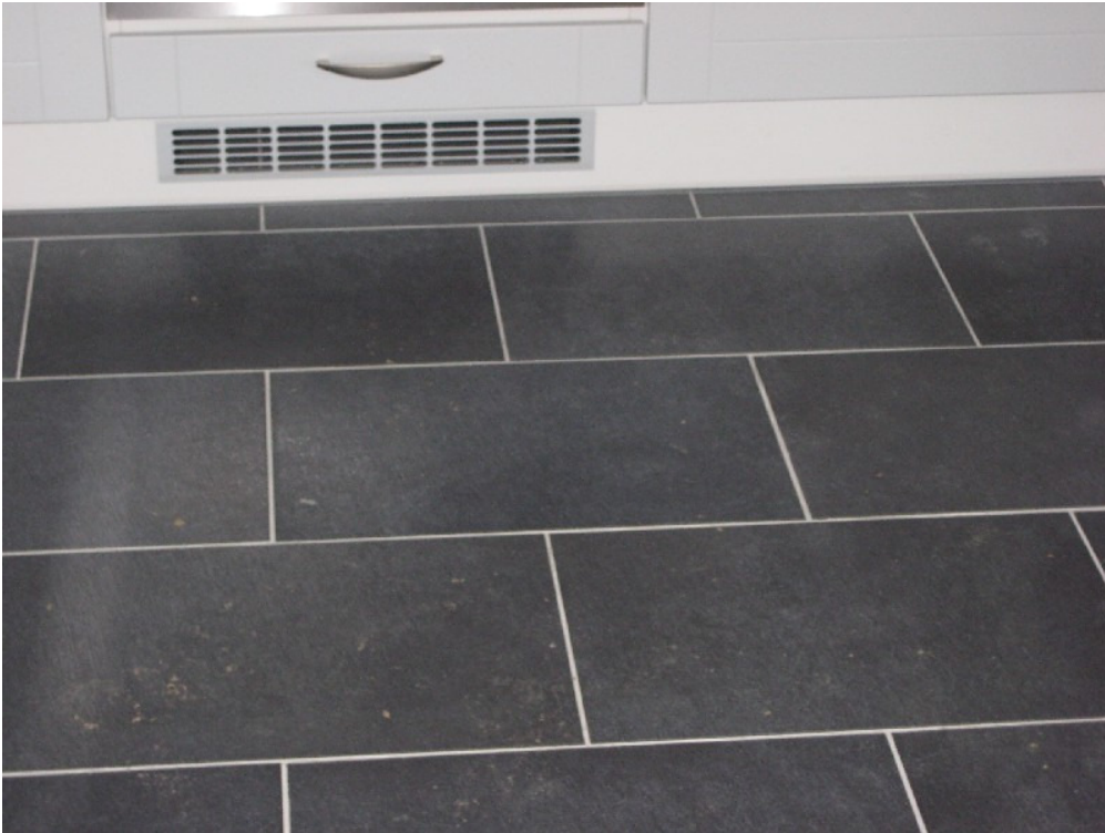
Kuva 14. Keittiön lattialaatta tiilikuvio[2].
