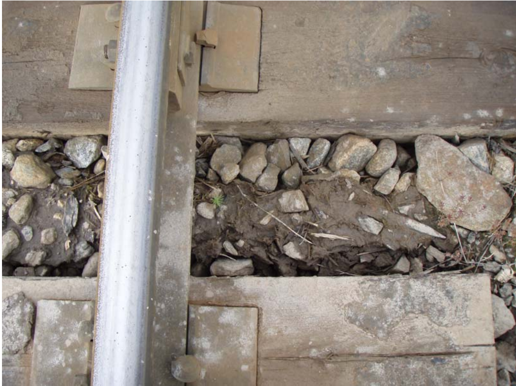
KUVA 37. Tukikerroksen läpi noussutta savea vaihteessa Pieksämäellä 2010
