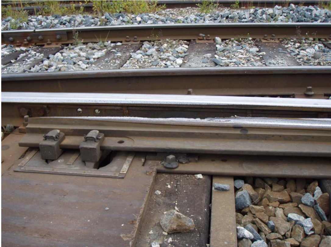
KUVA 35. Vaihteen kieli, josta on lohjennut paloja, Pieksämäellä 2010
