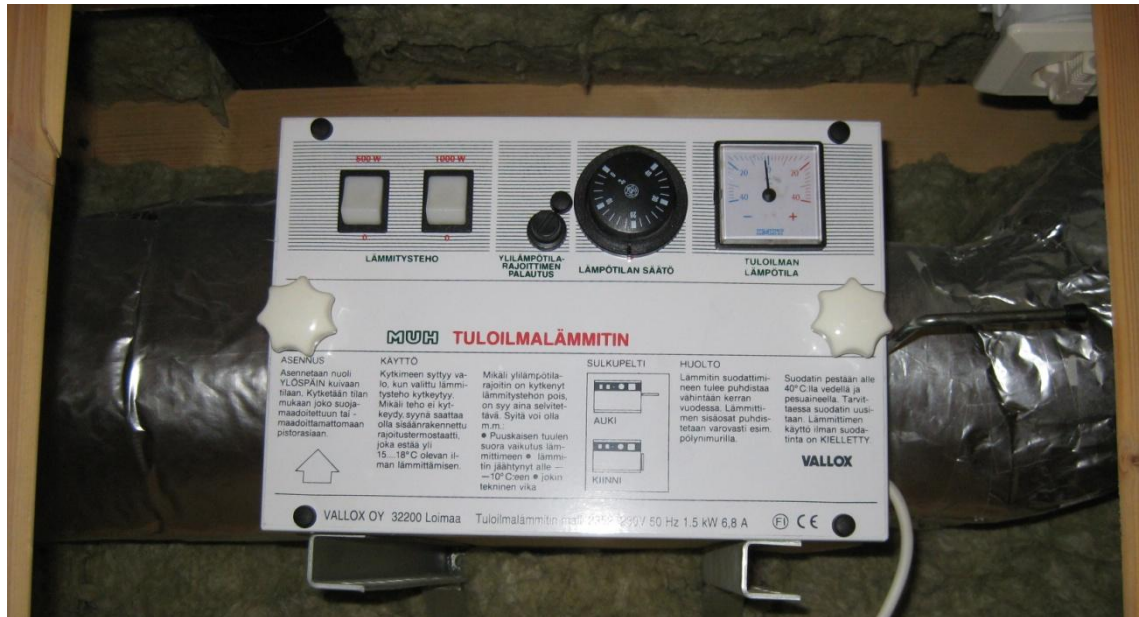
Kuva 22. Saunatiloihin ulkoilma kulkee lämmittimen läpi.
