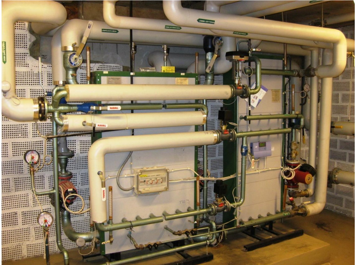
Kuva 24. Lämmönjakokeskus.
