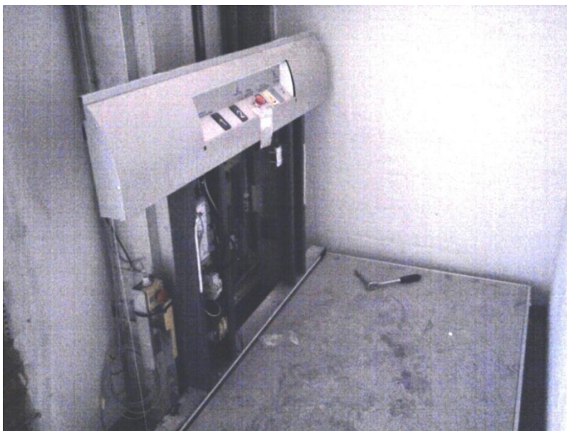
Kuva B. Aritcon lavan pellit on poistettu. Vasemmalta alkaen löytyvät hätäpuomi, piirikortti ja moottori.
