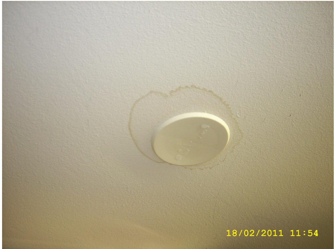
KUVA 19. Huoneesta 039 otettiin materiaalinäyte sisäkaton kipsilevystä suojakannen vierestä.
