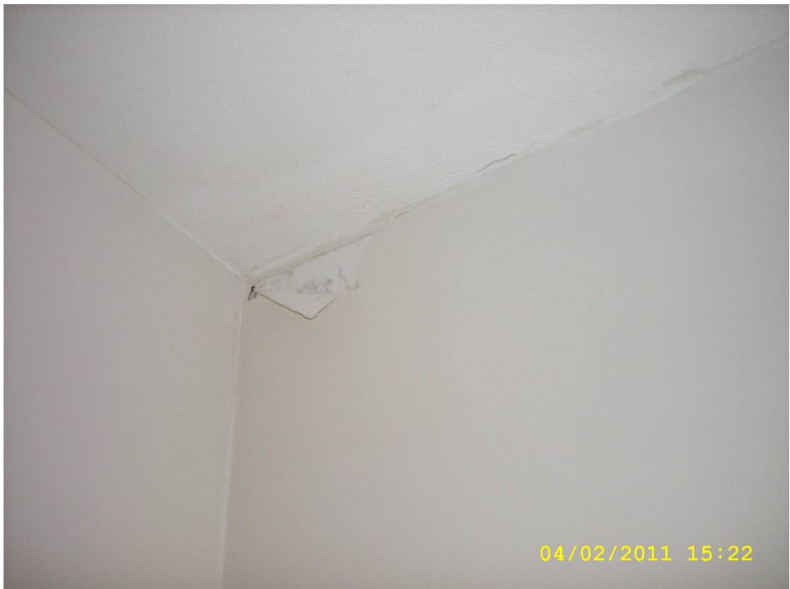
KUVA 18. Huoneesta 194 otettiin materiaalinäytteet ulkoseinän sisäverhouslevystä ja lämmöneristeestä.
