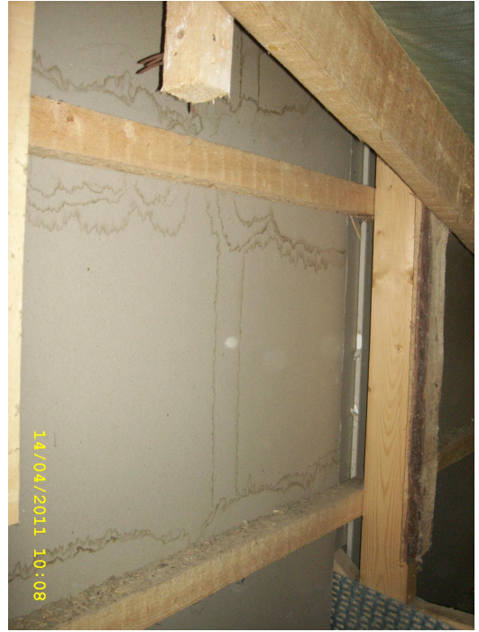
KUVAT 11 ja 12. Yläpohjatilassa sijaitsevia pieniä vesivuodon jälkiä.
