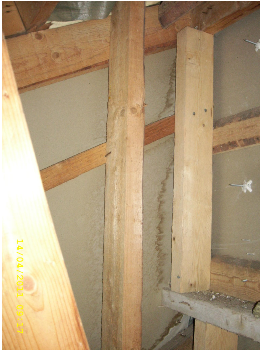
KUVAT 11 ja 12. Yläpohjatilassa sijaitsevia pieniä vesivuodon jälkiä.
