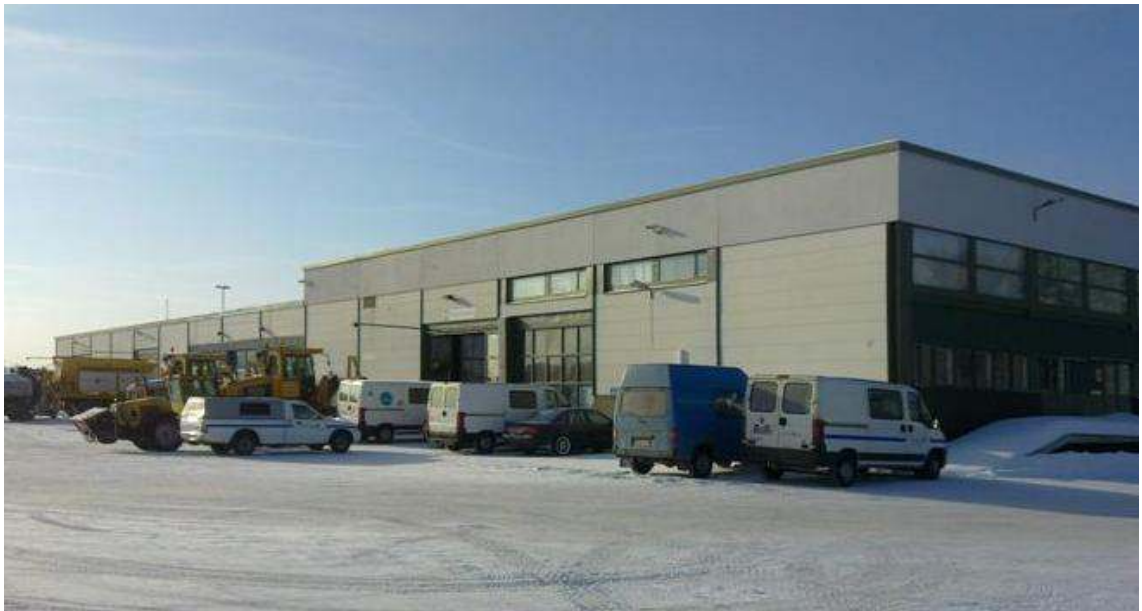
Kuva 1. Turun Kunnallistekniikkaliikelaitoksen Varikko.
