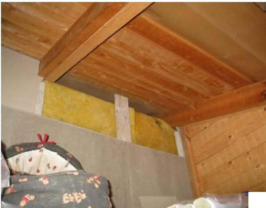
Kuva 19. Tuulensuojalevyn asennus on kesken
