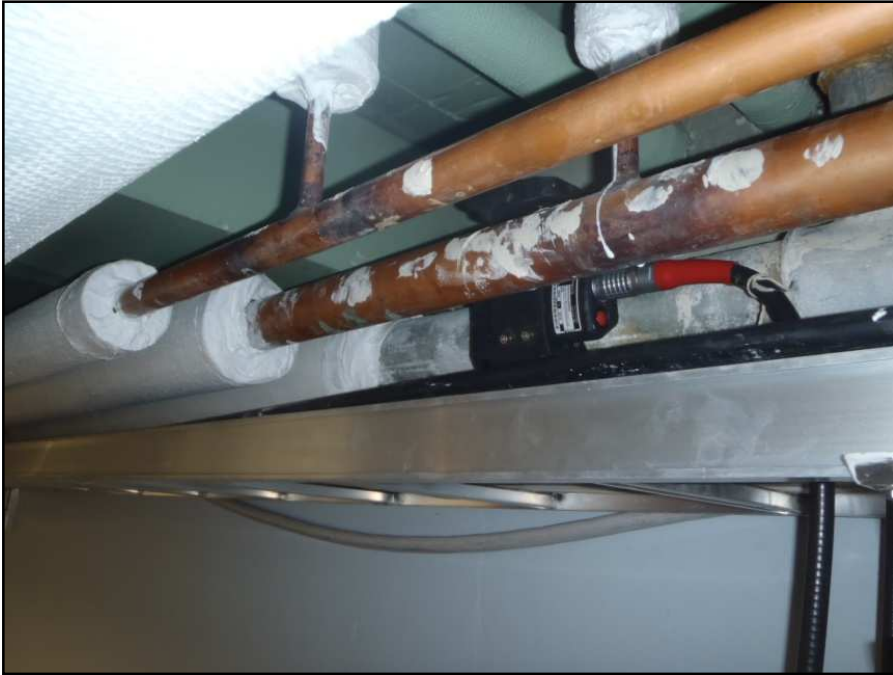
Kuva 36. Sinkityn kylmävesiputken testaus.
