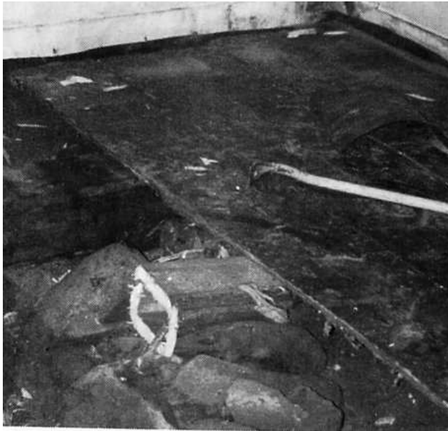
Kuva 4. (Tervo 1998.) Kuvassa näkyy puinen tuuletusputki.
