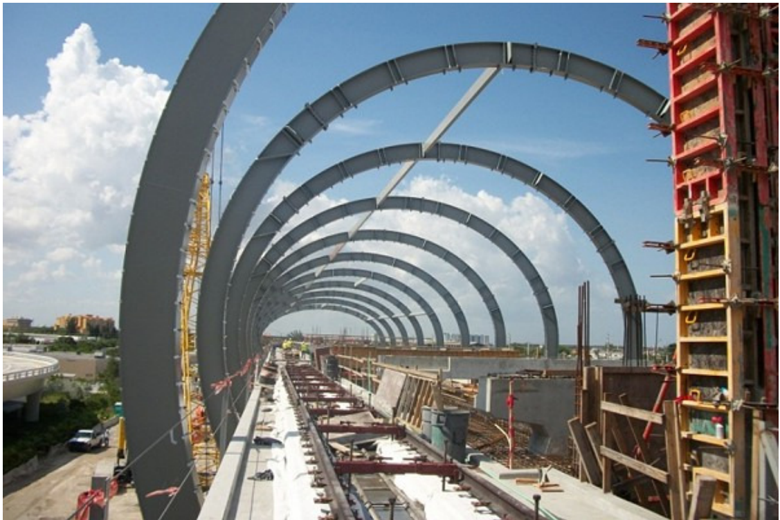
Kuva 2.2 Miamin lentokentän metroaseman pääkatoksen teräskaaret (Byers 2010)
