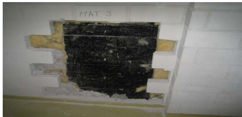
Kuva 3. Massiivinen betoninen kellarin seinämä, sisäpuolisella kosteus- ja lämmöneristyksellä ja mahdollisesti seinämässä on ns. verhomuuraus, kuten kuvassa on.
