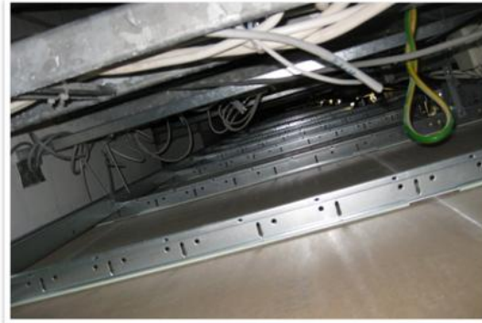
Kuva 2. Puhtausvaatimukset täyttävä alakaton päällys. Valokuva Sirpa Kolari 2011.
