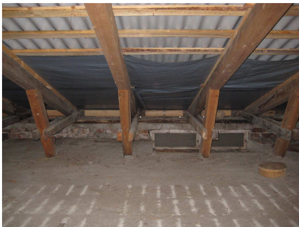
Kuva 34. Kahden metrin mittainen aluskate on asetettu vain katteen reunoille.
