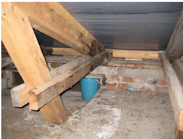
Kuva 33. Seinän ja katon liitoskohta on tukittu lankuilla.
