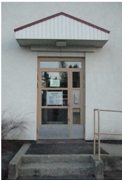
Kuva 16. Kirjaston pääsisäänkäynnin ovi on teräskehyksinen.
