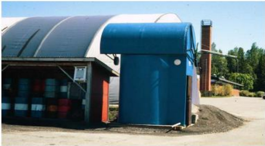
Kuvio 10 Liuosasema suolahallin ulkopuolella. /1, 47/
