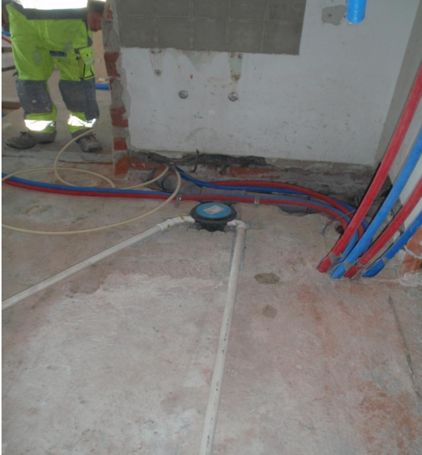
KUVA 5. Viemärit roilotettu välipohjalaattaan perinteisellä putkiremontilla
