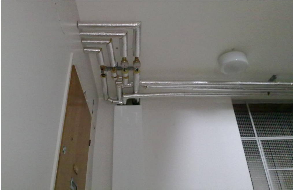
KUVA 9. Putkiasennuksia porrashuoneissa AS-elementtikoteloilla
