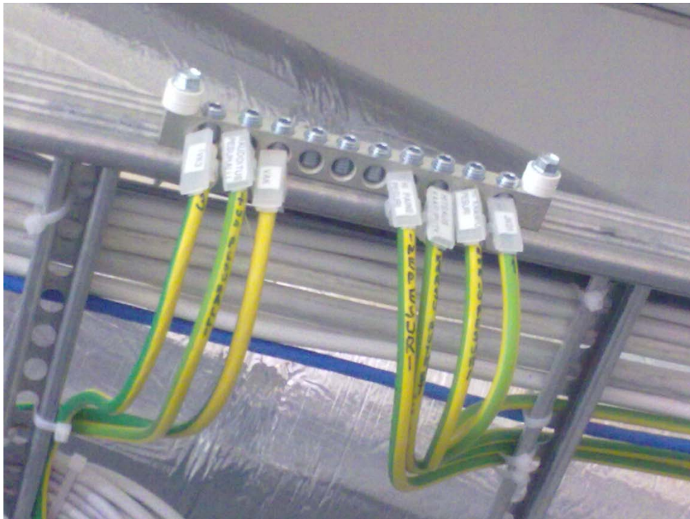
KUVA 4. Maadoituskaapeleiden päät kierretään kiinni kierrekiristysruuvein ja kisko kiinnitetään pultein kiinni kaapelihyllyyn.
