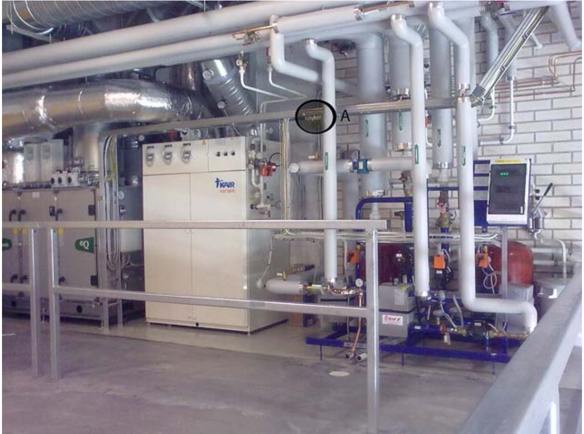
KUVA 6. Potentiaalitasauskisko, sijainti merkitty ellipsillä ja kirjaimella A. Kuvassa myös ilmanvaihtokojeisto huoltotasanteella
