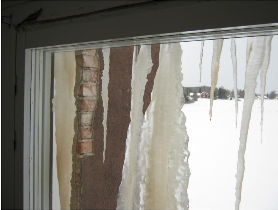
KUVIO 2. Jääpuikkoja keittiön ikkunalla, helmikuu 2010.
