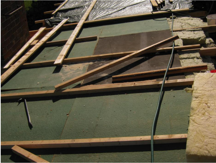
KUVIO 4. Vesikaton korjausta.
