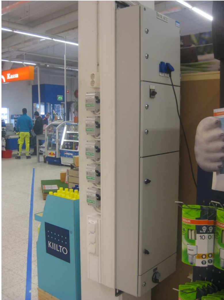
KUVIO 15. Uusi ryhmäkeskus asennettuna ja tarkastettuna
