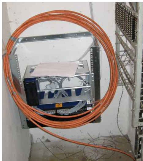
Kuva 18. Tilanne sisävetojen jälkeen
