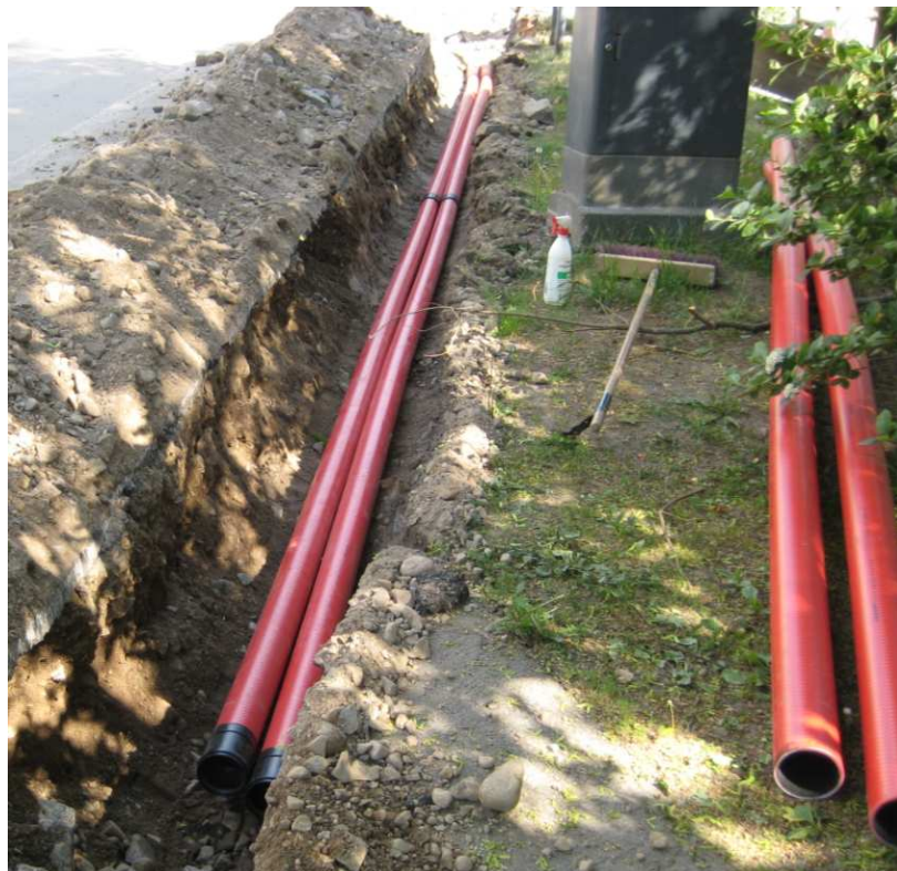
Kuva 11. Tyypillisiä kanavaputkia asennusvaiheessa
