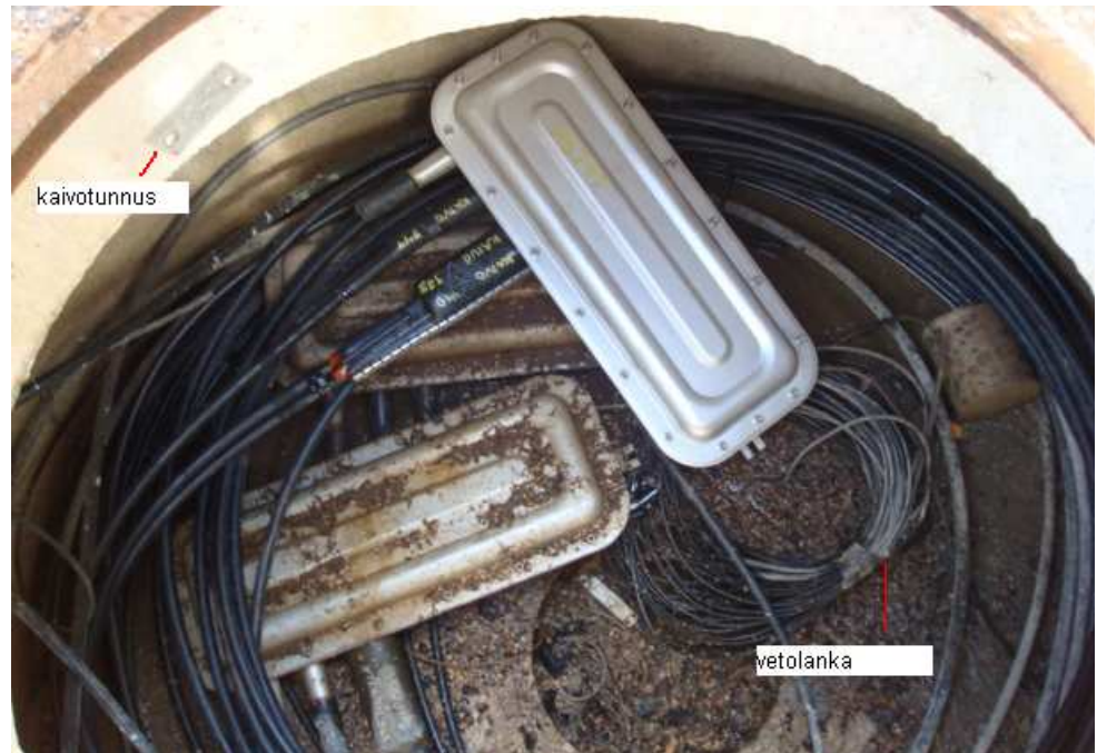
Kuva 22. Kaivo jossa useampi jatkoskotelo
