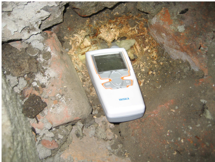
Kuva 31. HM40 käsimittarilla mitataan vanhan kattorakenteen kosteutta. TR 2011
