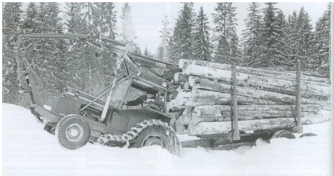
KUVIO 3. MF-MiniRobur varustettuna Cranab-kuormaimella ja puoliteloilla (Kotta 2008, 88)
