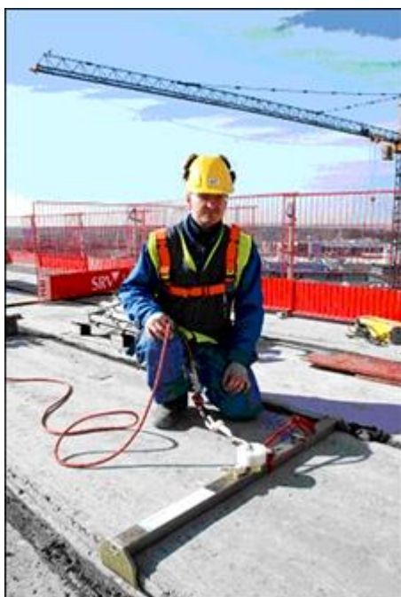
KUVIO 12. Ontelolaattatarrain (Betoniteollisuus ry)
