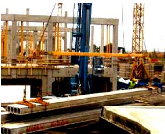
KUVIO 11. Nostopuomi ja -saksit (Betoniteollisuus Ry)
