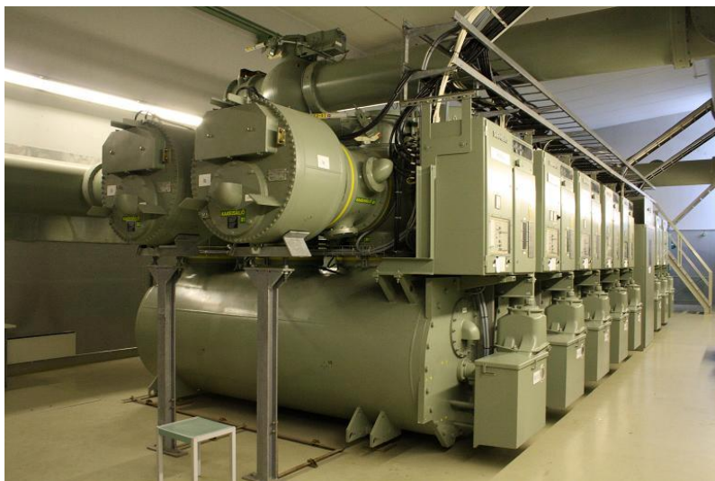
Kuva 3. 110 kV SF 6 -kaasueristetty GIS-kojeisto
