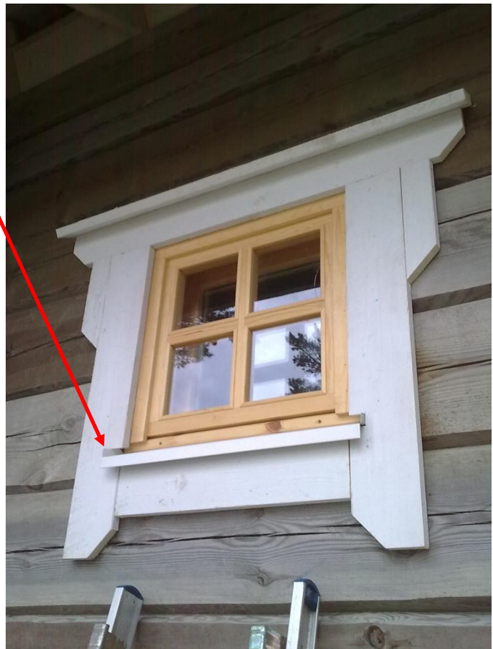
Kuva 102. Ikkunapelti ja pielilaudat valmiina.
