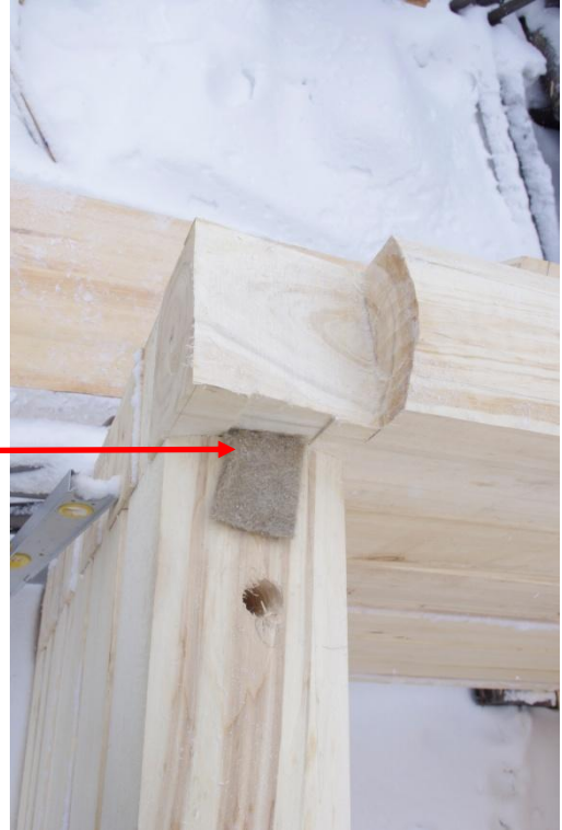
Kuva 31. Lyhyen nurkan yläpuolinen eristäminen.
