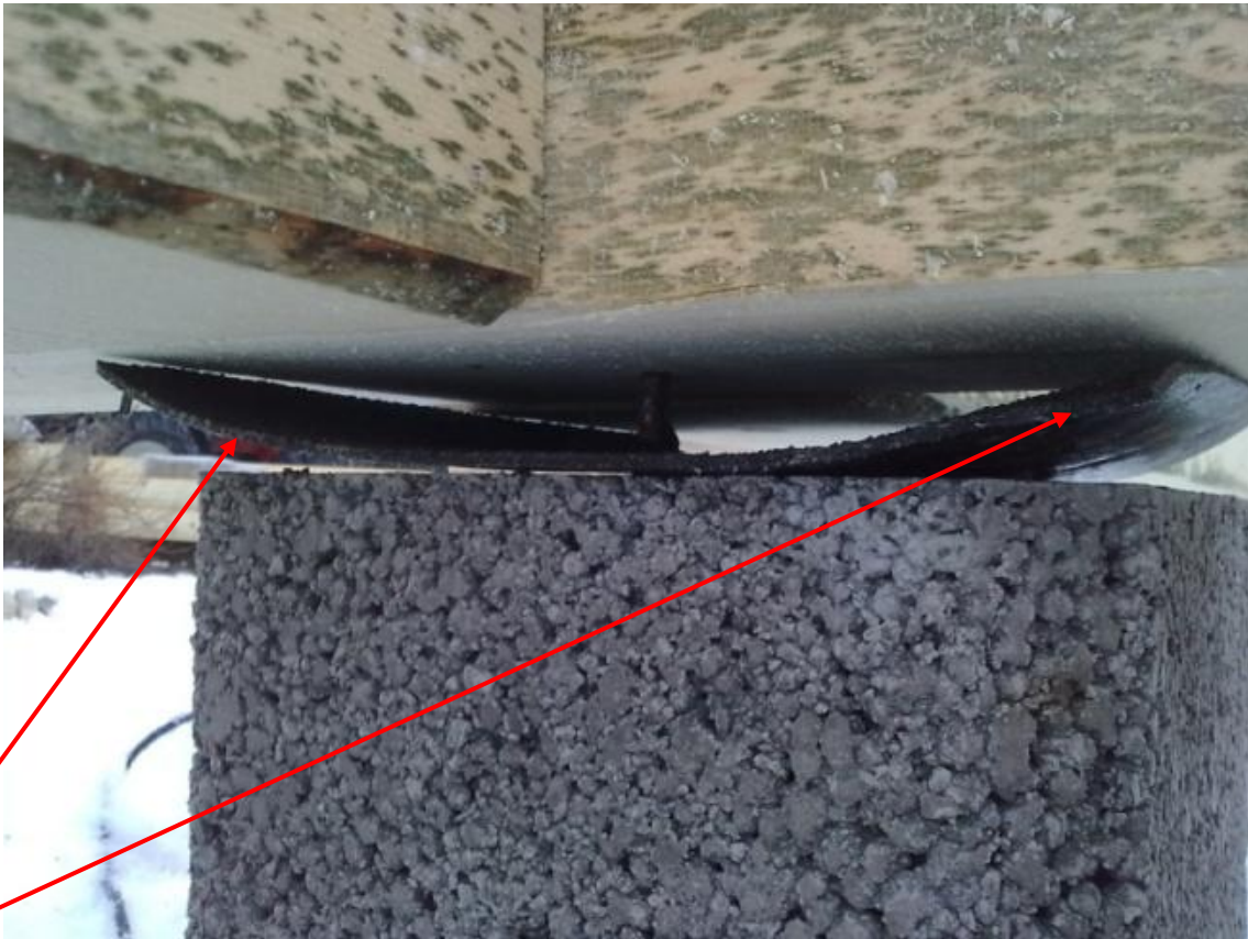
Kuva 18. Puupalat on poistettu ja hirtä lyöty paikalleen. Kuvassa näkyvä sokkelikaista on paikallaan ja hirsi voidaan lyödä pohjaan asti.
