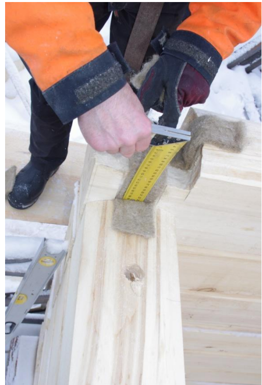
Kuva 32. Lyhyen nurkan yläpuolinen eristäminen. Suorakulmaa käyttäen varaukseen työnnetään saumanauha.
