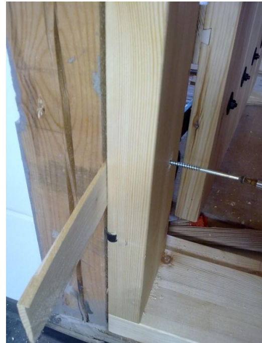
Kuva 55. Oven karmi ruuvataan kiinni kiilan läpi karalankkuun.
