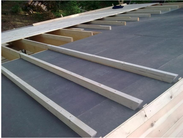
Kuva 66. Katto rakenteilla. Kuvassa näkyy tuleva tuuletusväli. Tuuletus on toteutettu 50x100 sahatavaralla, joka on ruuvattu tuulensuojalevyn läpi 50x200 kattokannattajaan. Bitumikermin aluslaudoituksen asentaminen on aloitettu räystäältä.
