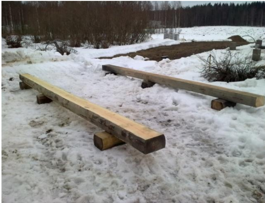
Kuva 20. Hirsitelat on asetettu villoitus telineeksi.
