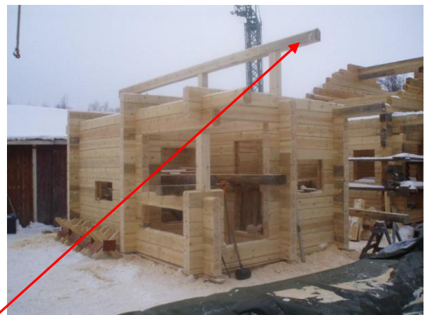
Kuva 70. Pilarien päälle asennettu kurkihirsi.
