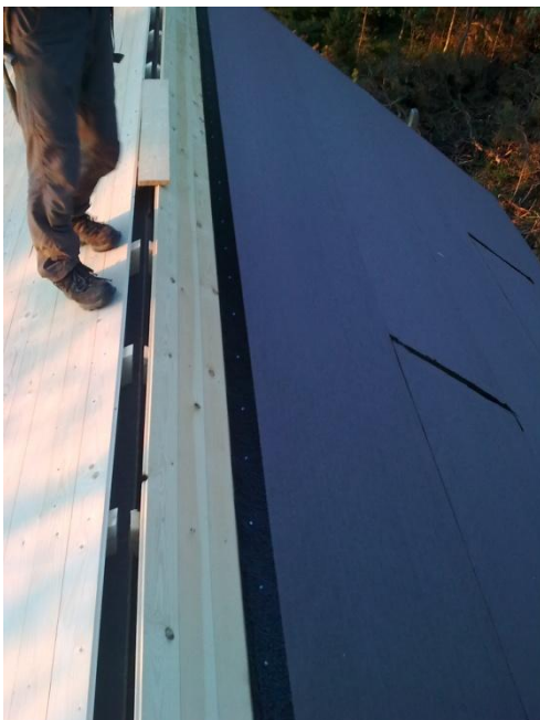
Kuva 67. Harjalle on jätetty 30–50 mm leveä tuuletusrako harjatuuletusta varten.
