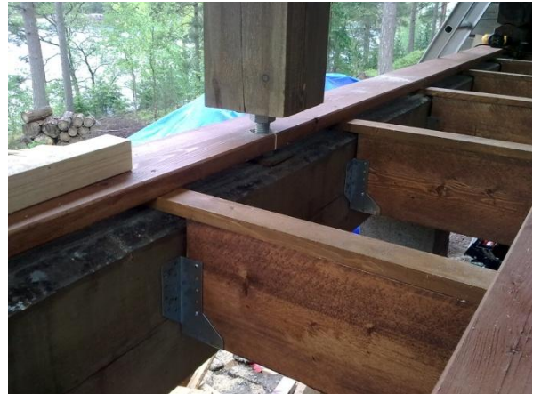
Kuva 80. Kuvassa ulkoterassin lattiavasojen asennus palkkikengkiä apuna käyttäen.
