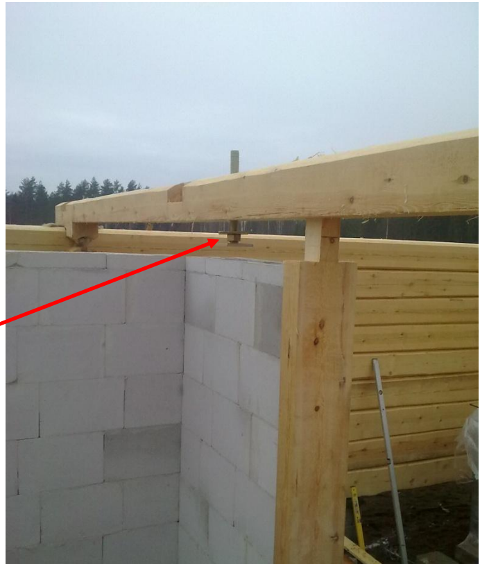
Kuva 38. Kierretanko on asetettu paikalleen muuratunseinän päällä.
