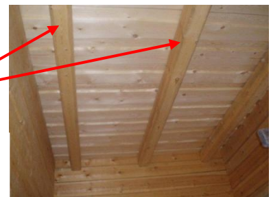
Kuva 13. Vuoliaiset tukevat välipohjan lattiarakenteita.
