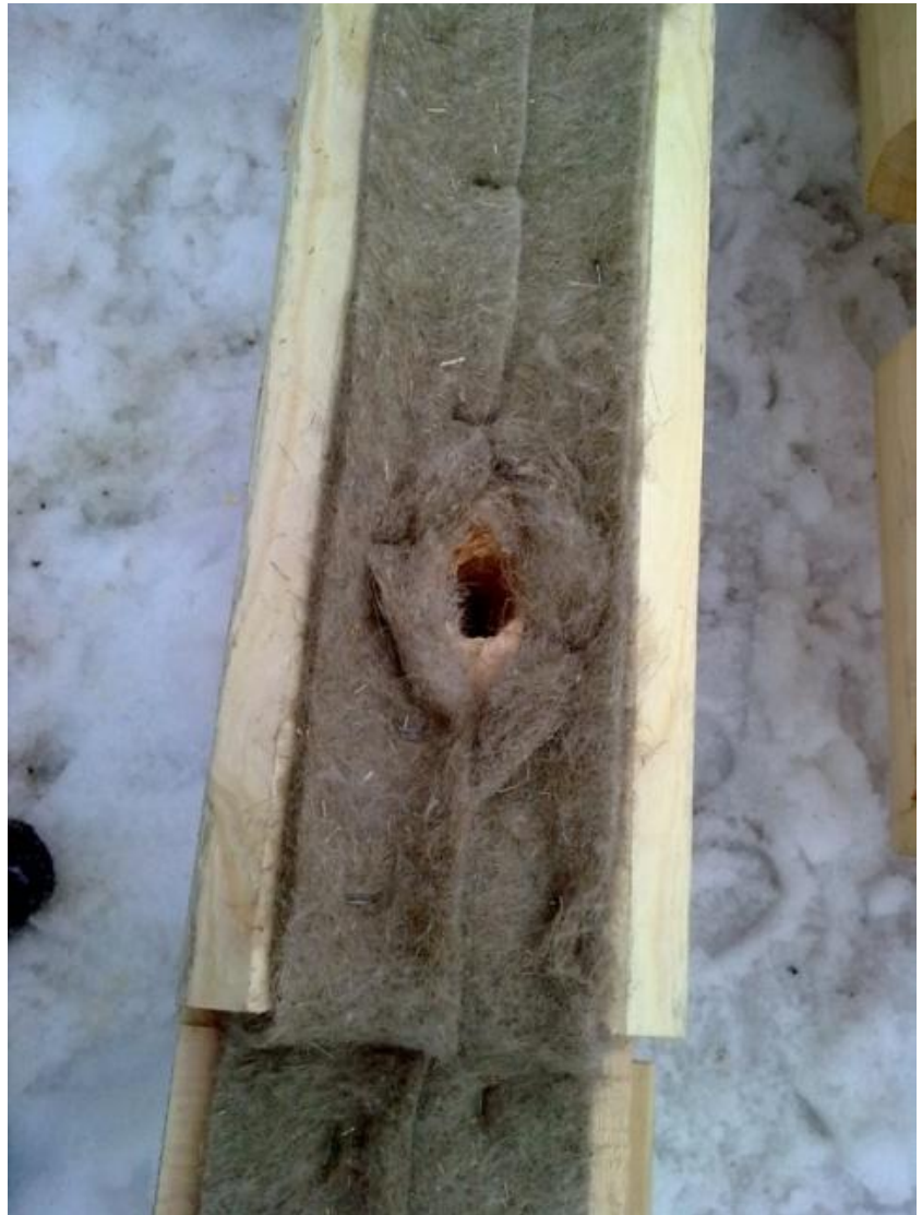
Kuva 23. Tapinreiän kohdalla eriste on taitettu.
