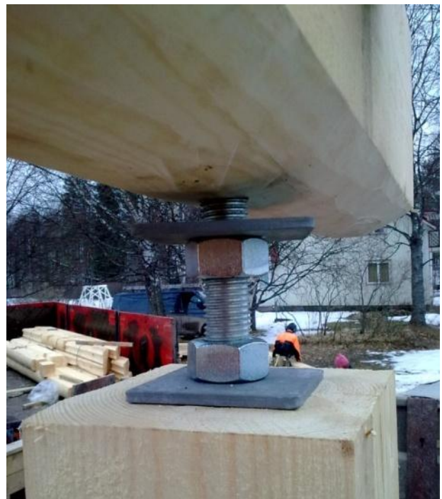
Kuva 36. Kierretanko on asennettu paikalleen. Mutteri on vielä kirimättä.
