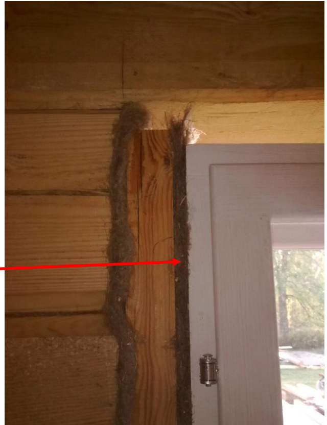
Kuva 51. Karalankun ja ikkunakarmin väli on täytetty saumanauhalla
