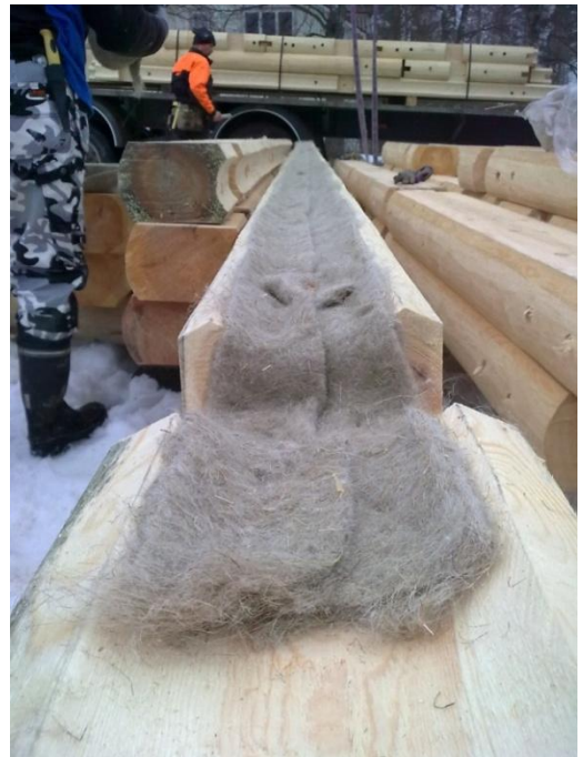
Kuva 22. Hirsi valmiiksi eristettynä. Saumaeriste ei mene varauksen yli.
