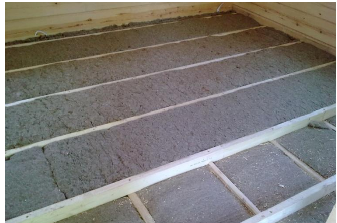
Kuva 86. Kuvassa lattiavasojen väliin on asennettu eriste. Ristikoolaus on asennettu ja eriste osittain asennettu.
