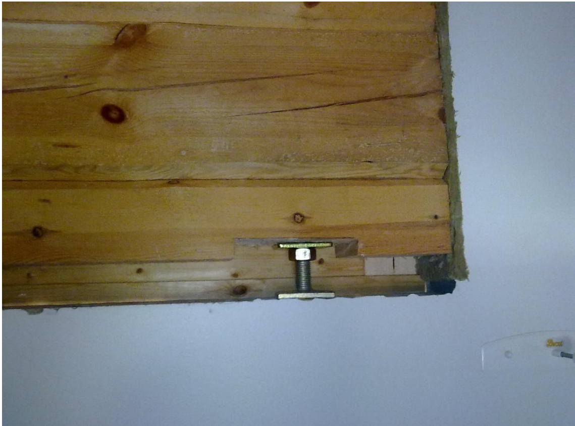
Kuva 39. Kierretanko on asetettu paikalleen muuratun seinän päällä. Hirttä on kolottu aluslevyn ja mutterin verran.
