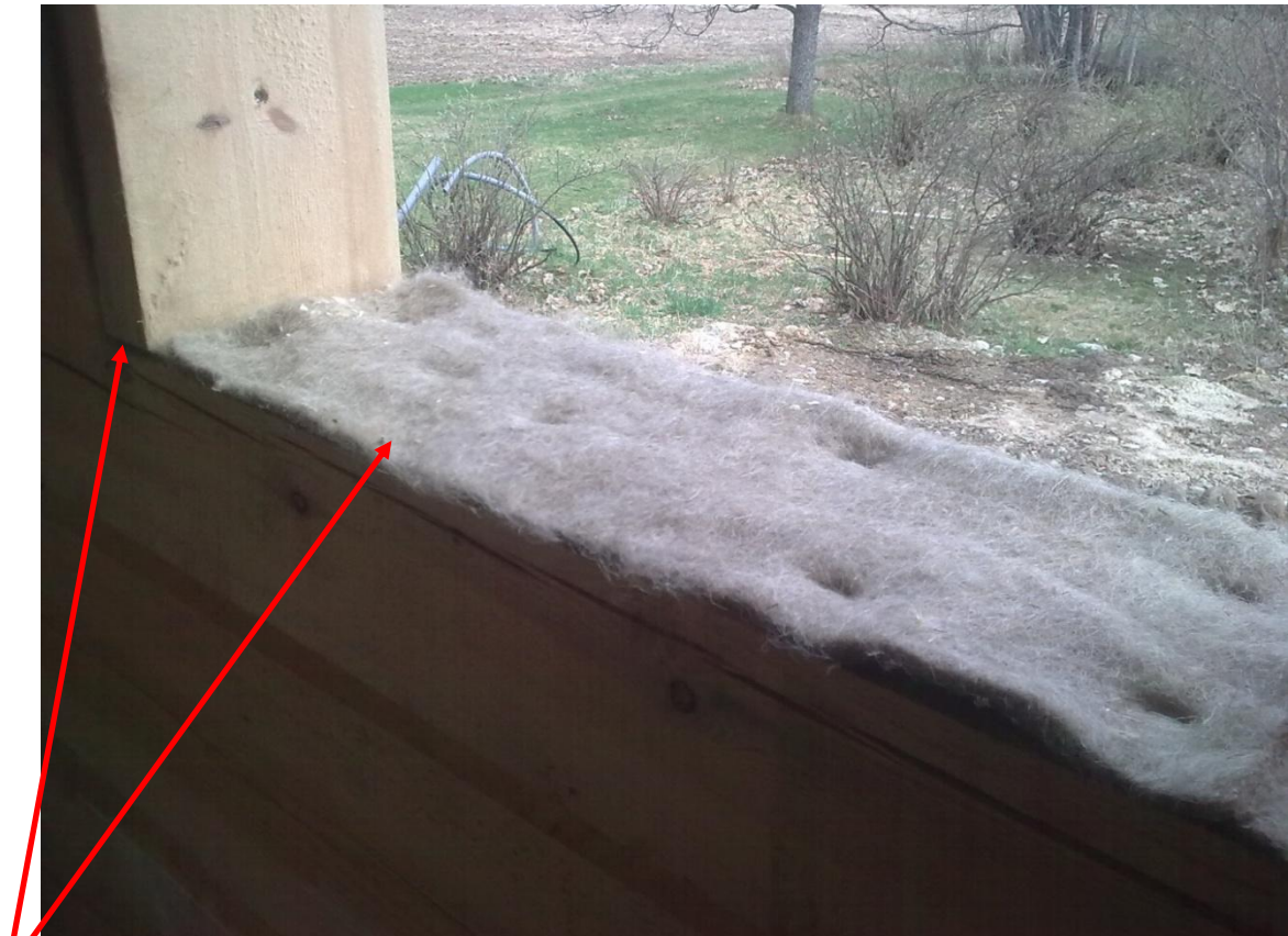
Kuva 45. Ikkuna-aukon alapintaan on asennettu leveä eristekaista, joka jatkuu karalankun alle.
