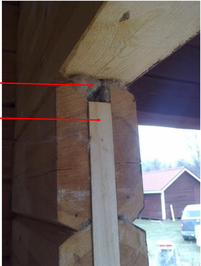
Kuva 43. Karapuu on asennettu paikalleen ja siihen on jätetty painumavara.
