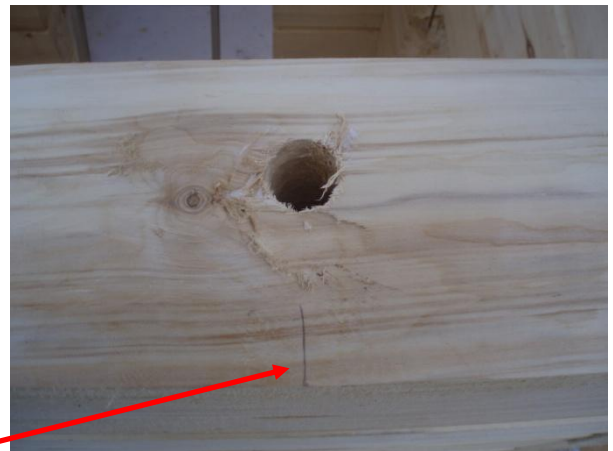
Kuva 15. Tapin lyöntireikä on merkitty viivalla.
