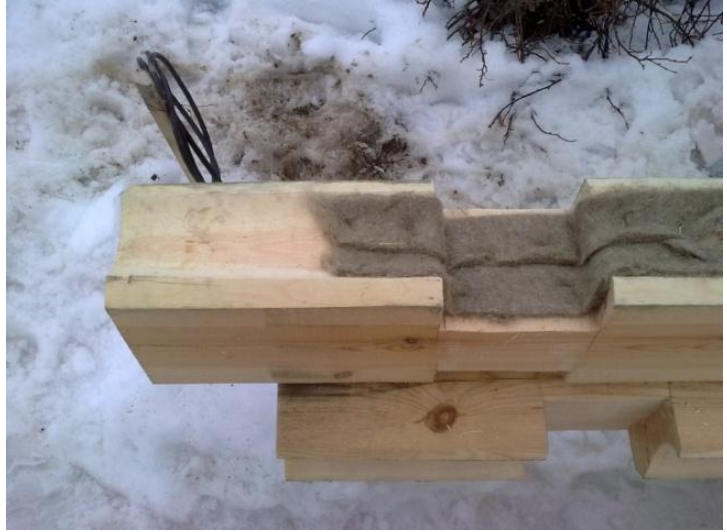
Kuva 21. Hirren ulkonurkan eristys. Kuvassa on kaksi pellavavilla saumanauhaa.
