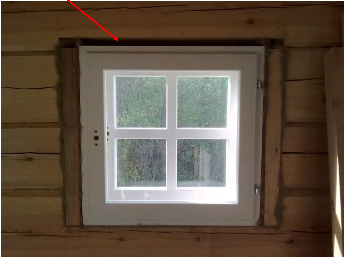
Kuva 52. Ikkunan eristys valmiina.
