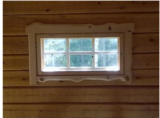
Kuva 103. Ikkunan pielilaudat on tehty halkaistusta tuppilaudasta.
