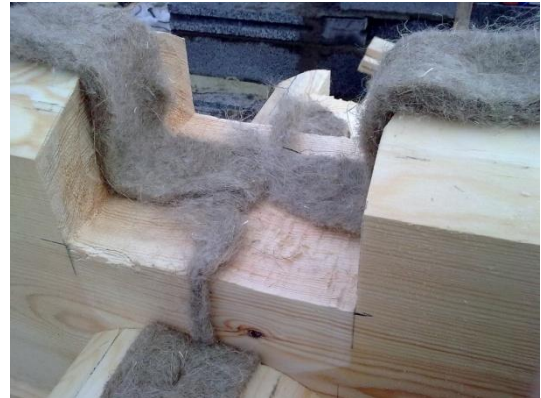
Kuva 27. Hirren jatkaminen. Kuvassa on eristeikaista asennettu menemään salvoksen yli.
