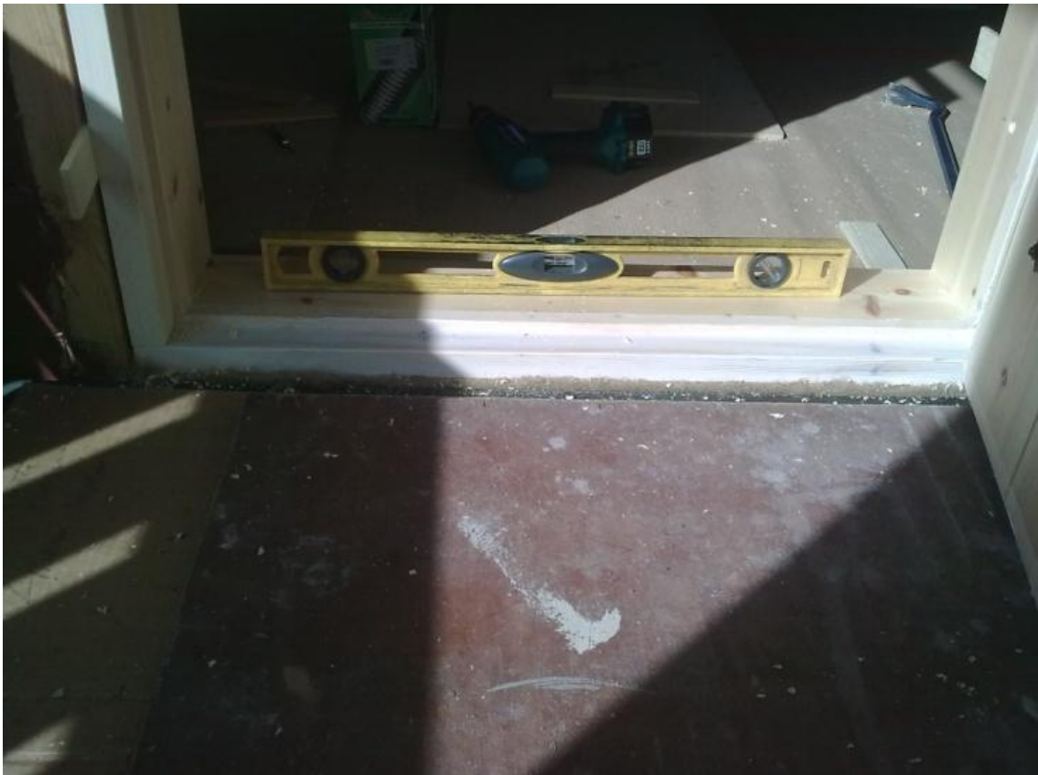
Kuva 53. Ovi nostettu paikalleen pellavavillan päälle, vatupassilla tarkistetaan oven kynnyksen vaakasuoruus.
