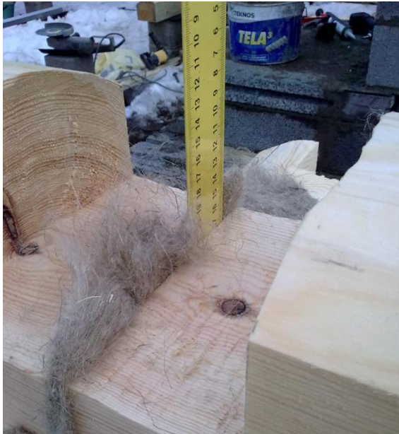
Kuva 26. Hirren jatkaminen. Kuvassa eristeikaista työnnetään hirsien saumaan.
