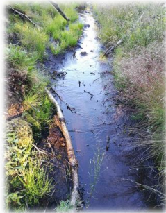
Kuva 16 Susisuon laskuojan penkat on kaivettu loivemmiksi turpeisen maaperän takia.
