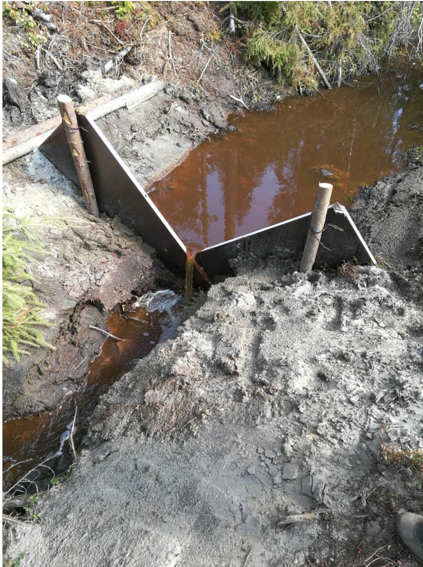
Kuva 8. Metsäkeskuksen Olli Lukanniemen suunnittelema V-mallinen pohjapato. Rakenne on edullinen ja yksinkertainen toteuttaa, lisääntyneenä pudotessaan vesi ilmastuu matkalla.
