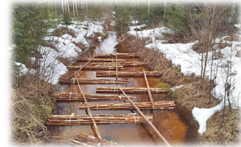
Kuva 9 Laskeutusaltaaseen laitettuja puunippuja. (2019, SYKE). Tässä kuvassa nippuja on huomattavan paljon altaassa. Tässä tapauksessa nippujen määrään edesauttaa viipymän pitenemistä altaassa, kuvan puut näyttävät melko tuoreilta ja tutkimustulosten mukaan haittoja ei koidu tuoreen puun käytöstä. Puut on helppo nostaa pois ja vaihtaa tarvittaessa.
