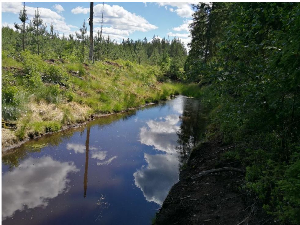
Kuva 9. Lautaportaanjärven eteläpuolella sijaitseva laskeutusallas. Altaan mitat ovat noin 4 x 25 m, sekä kaivuutöistä läjitetyt maat on läjitetty altaan sivuille vieden suunnilleen altaan kokoisen tilan myös.
