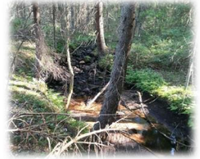
Kuva 14 Luonnonomukaisen kiviportaan kohdalla uoman korkeus muuttuu paljon lyhyellä matkalla ja vesi on päässyt syömään paljon maa-ainesta reunoilla.
