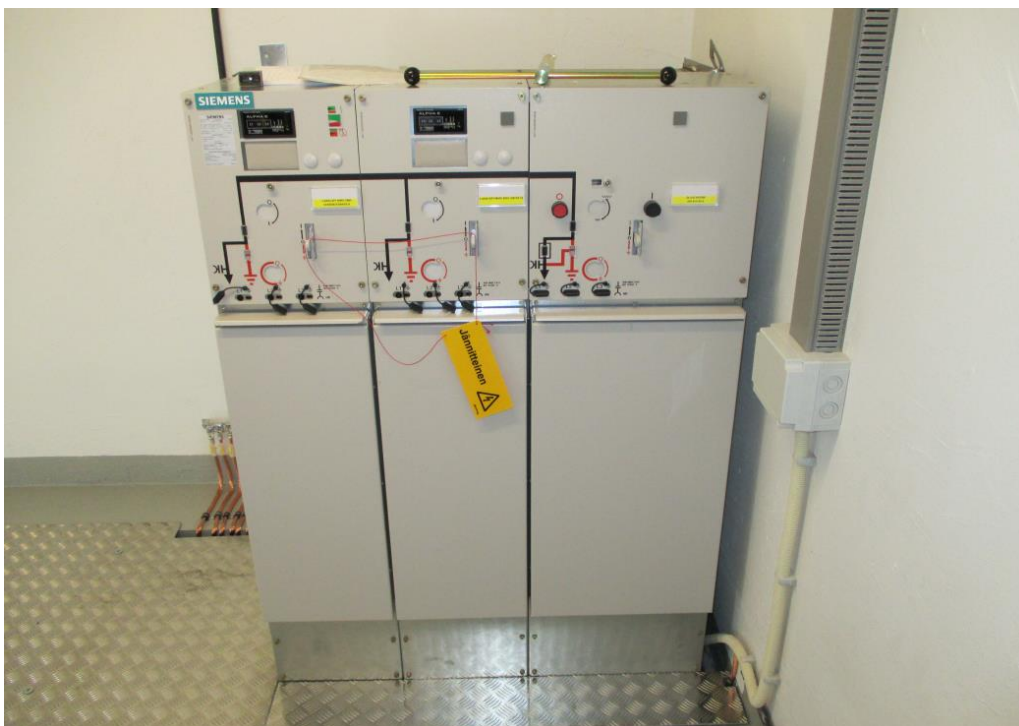
Kuva 7. Esimerkkikuva HSV:n käyttämästä RMU-kojeistosta.
