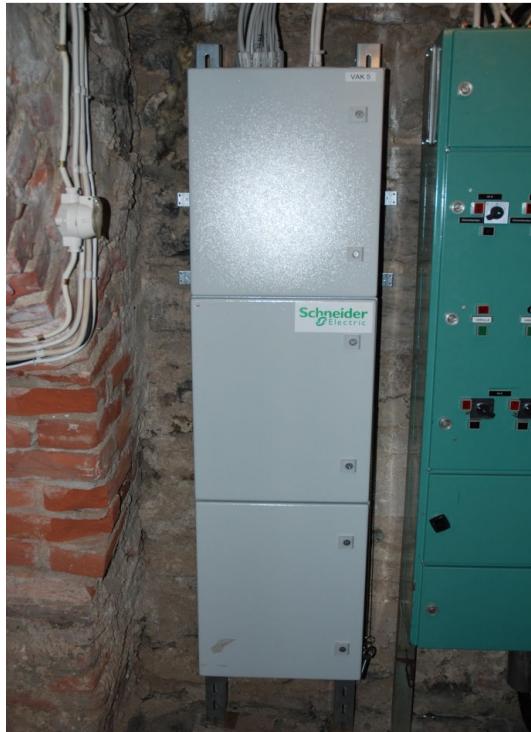
KUVA 6. Ahtaan kulkuaukon takia palasista rakennettu VAK 5 asennettuna
