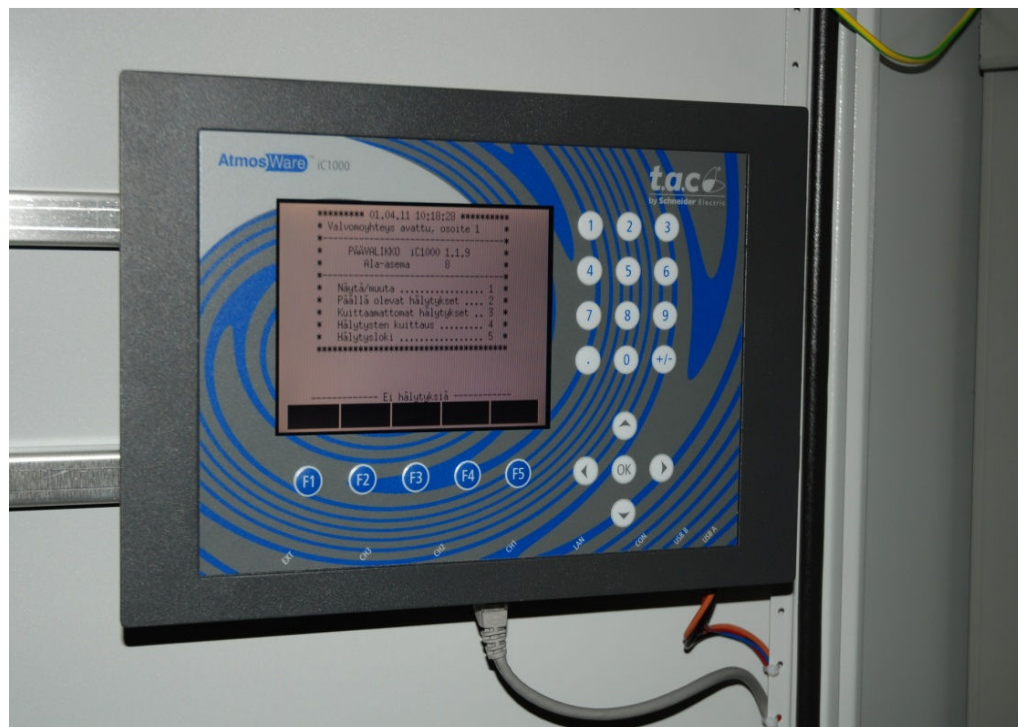
KUVA 7. Alakeskuksen IC1000 –keskusyksikkö
