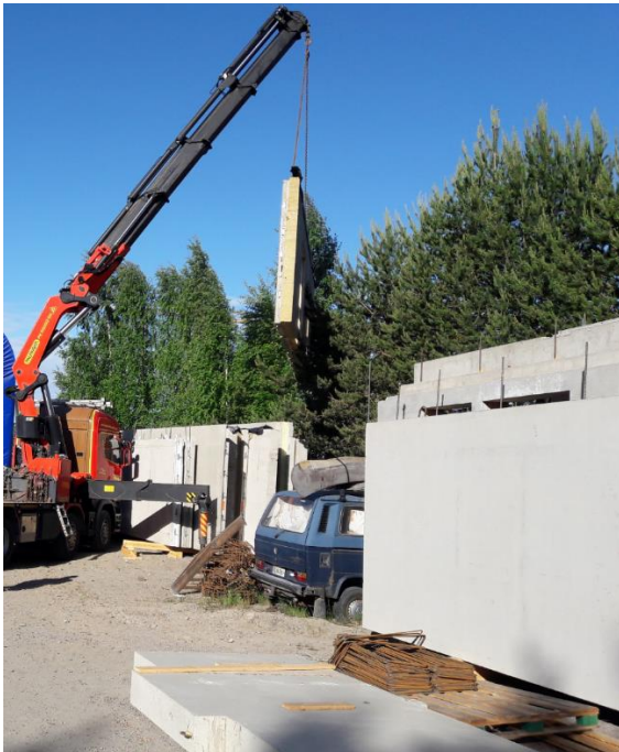
Kuva 5. Elementtien lastaus ja kuljetus välivarastolta työmaalle.
