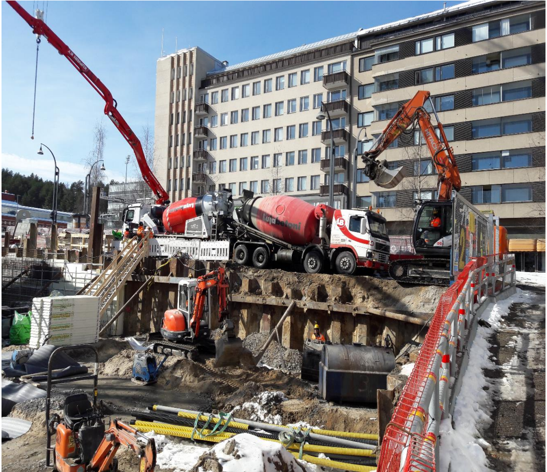
Kuva 1. Tontin maksimaalinen hyödyntäminen keskustan rakennustyömaalla.
