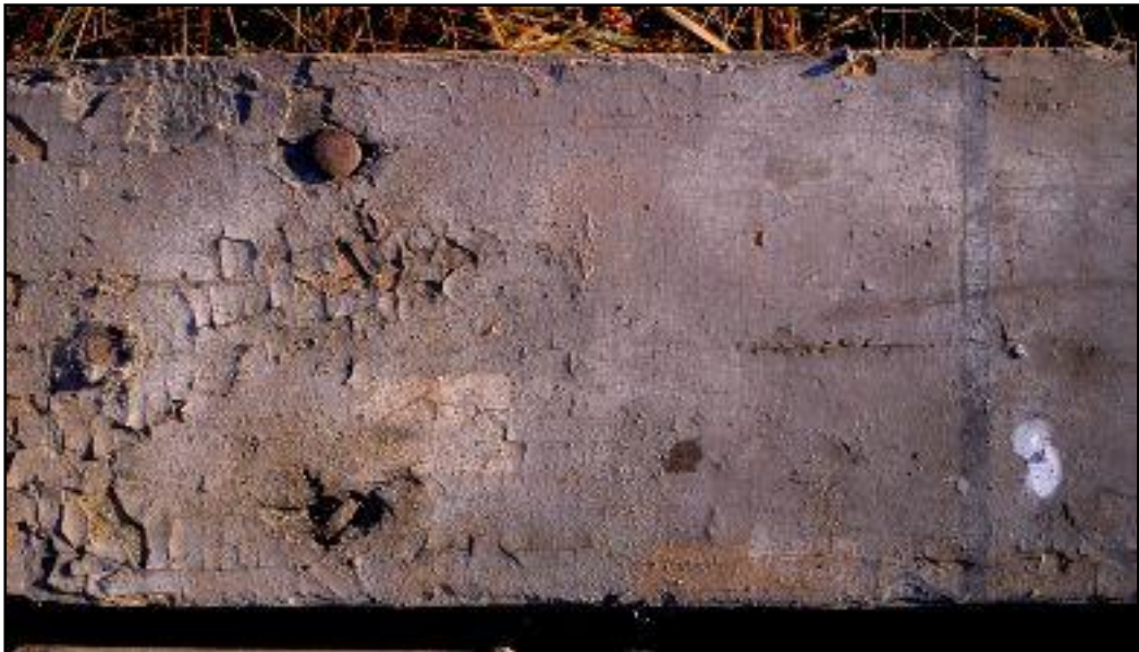
Kuva 13. Lohkeillut maalipinta
