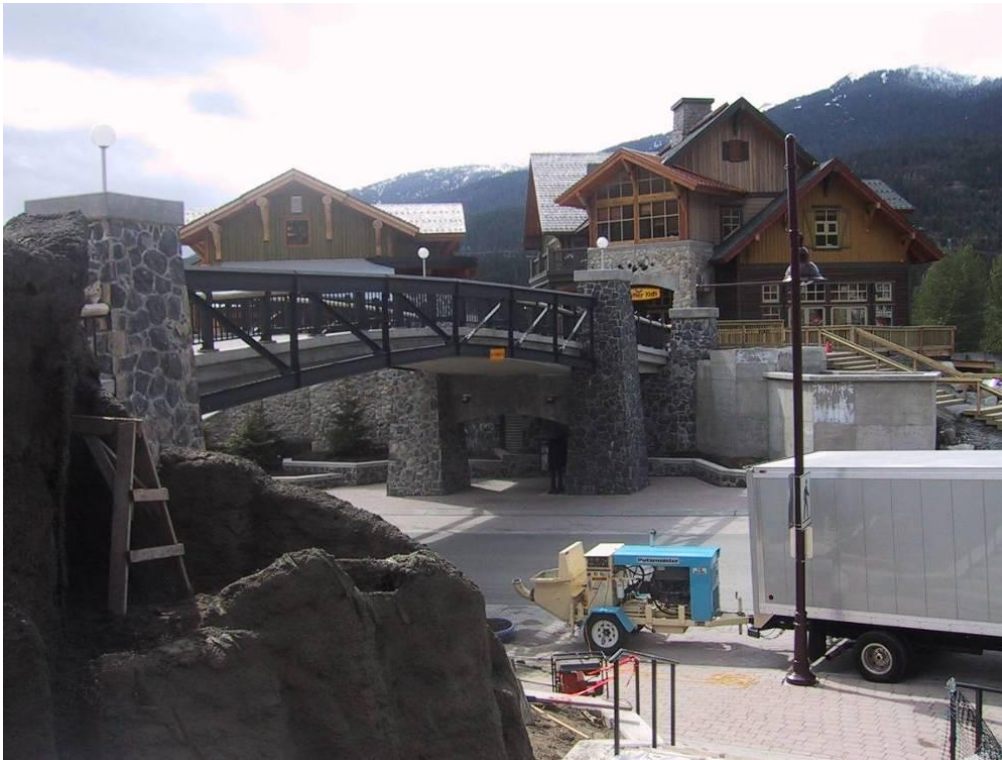
Kuva 18. Kulkua helpotetaan silloilla. (Kuva Niva)
