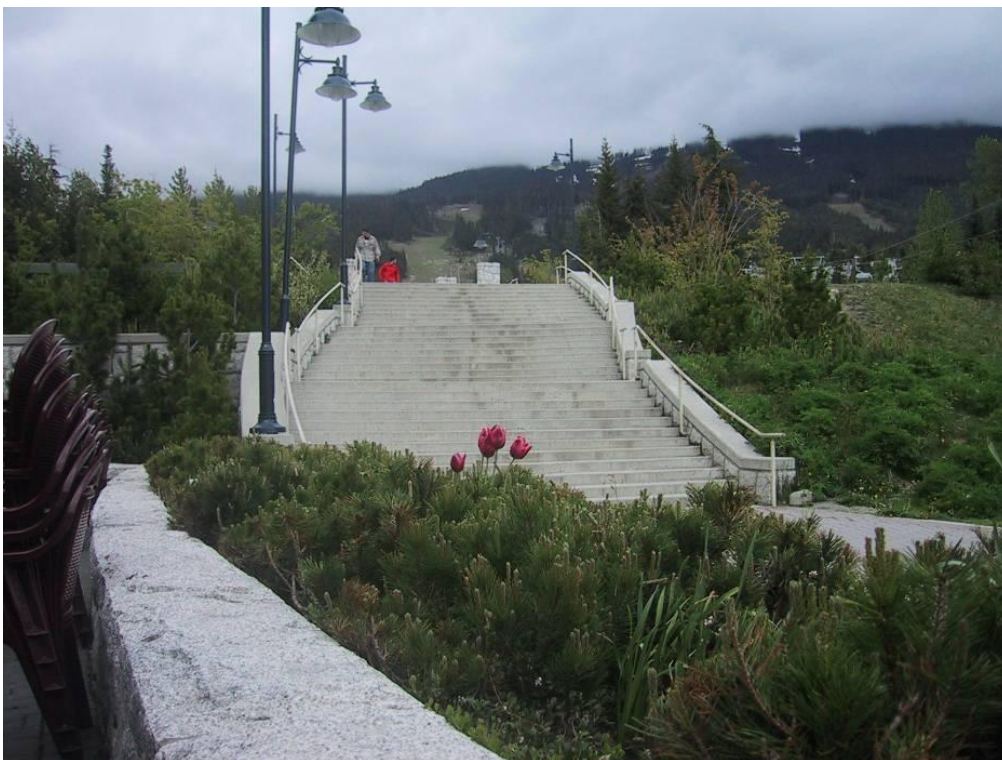
Kuva 19. Katuvalaistusta kävelyreitinvareilla. (Kuva Niva)
