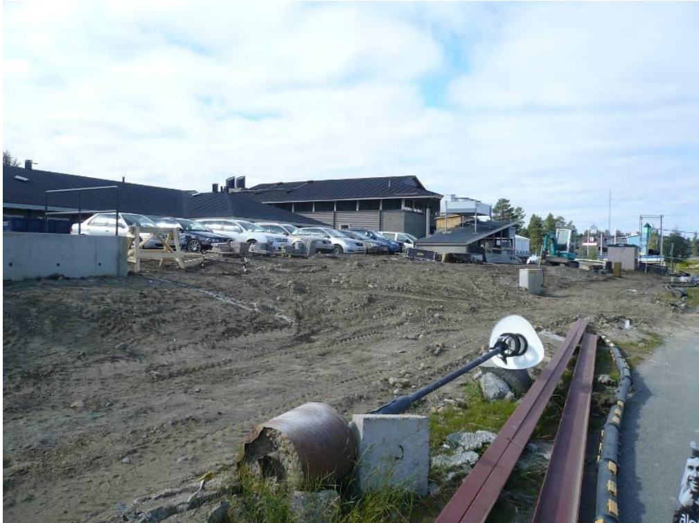
Kuva 22. Voimakas rakentaminen näkyy kyläilmeessä.
