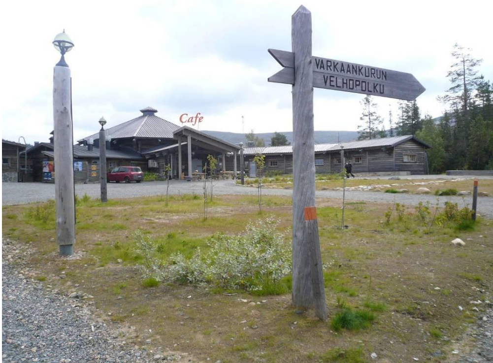
Kuva 3. Pohjoinen piha on karu. Ylläs 2010.
