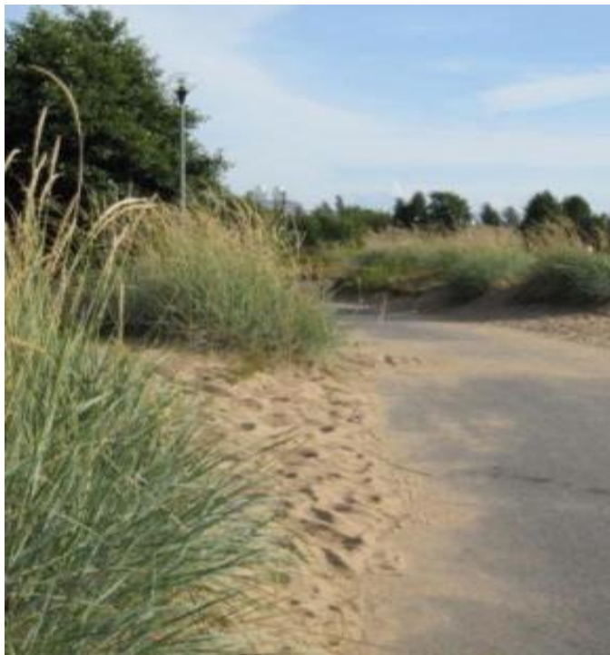
KUVA 2. Nallikarin ranta-alueella hiekka on peittänyt alkuperäiset nurmialueet ja vaikeuttaa Aallokkopolun kunnossapitoa.
