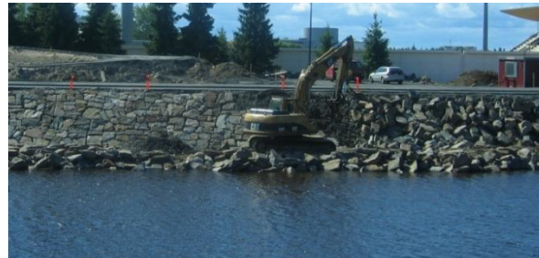
Kuva 17. Koneellisesti ladotun, järjestetyn kiveyksen rakentamista Oulujoella Raatin rannassa kesällä 2010.
