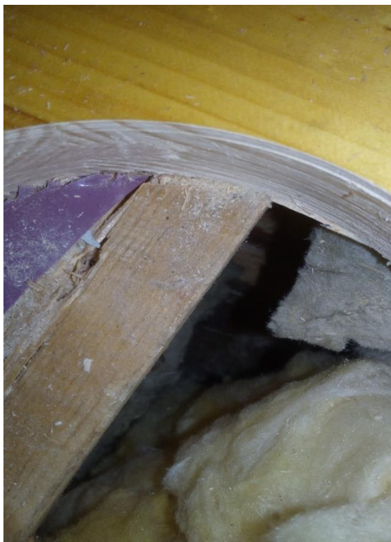
Kuva 4: Alapohjaan tehty koereikä (Karhunen 2019-11-30)
