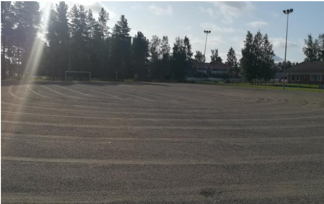
KUVA 5. Vasta lanattu kivituhkakenttä
