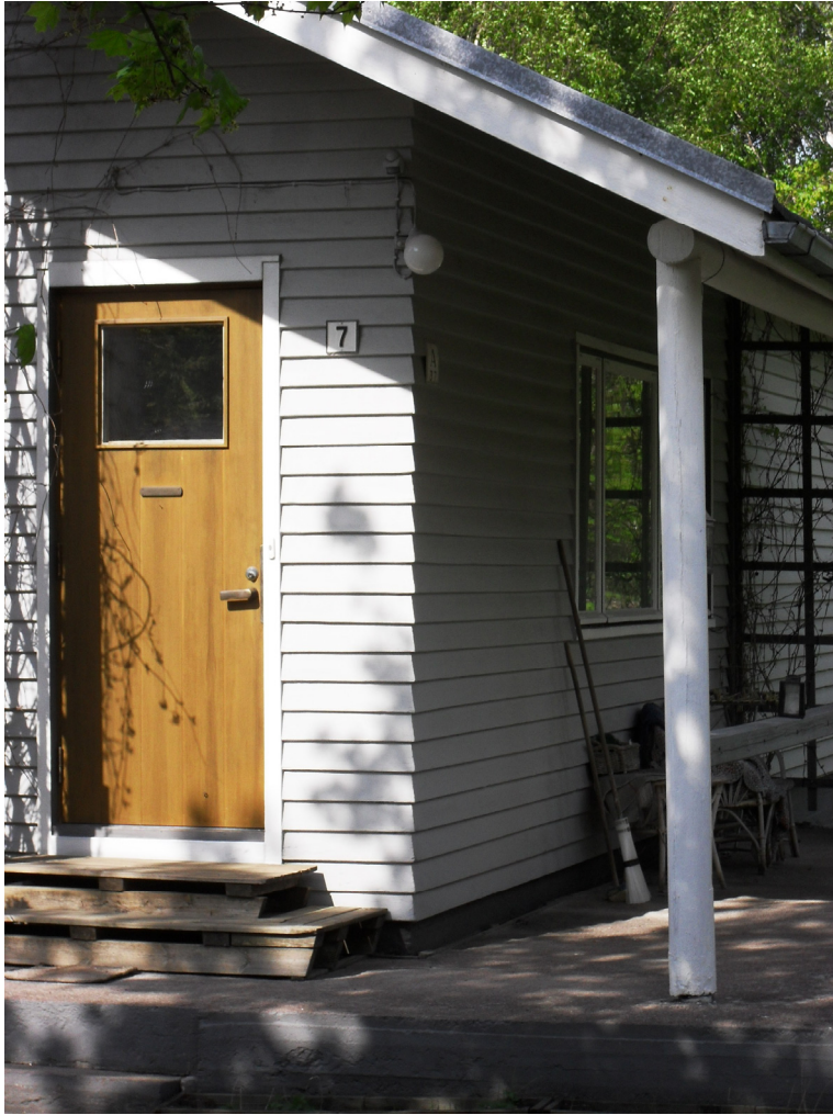
Kuva 13. Puistolan tyyppitalo alkuperäisin vaakalimilaudoituksin ja kulmajiirein (Hokkanen 2011).
