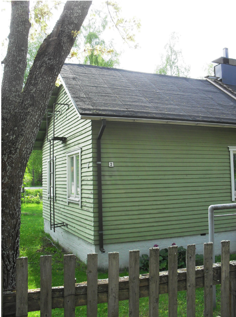
Kuva 15. Puistolan tyyppitalo suositeltavalla rullabitumihuovalla katettuna (Hokkanen 2011).
