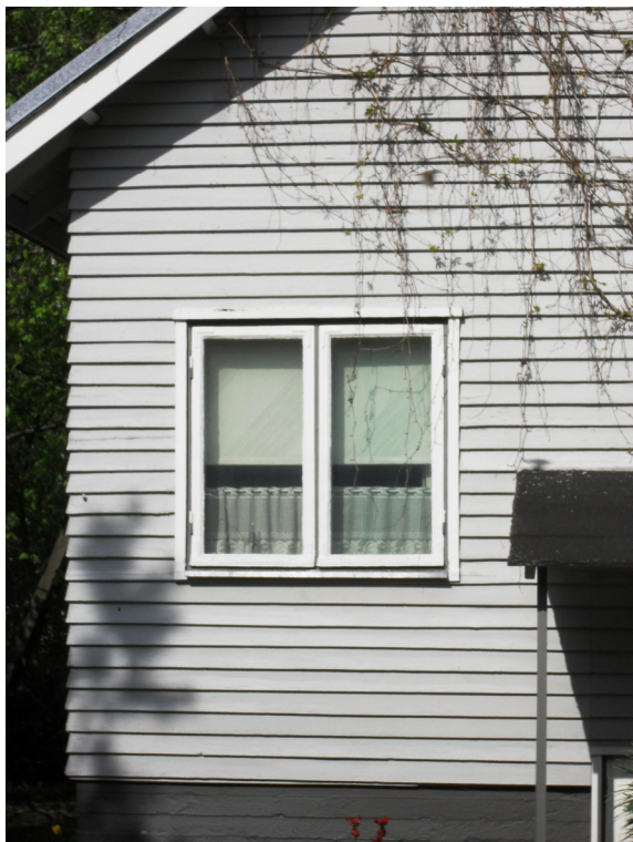
Kuva 17. Puistolankujan talo numero 7 on alkuperäisimpänä säilynyt kaikista Puistolalan taloista. Vain siinä on vielä alkuperäiset kapeat ikkunalistat (Hokkanen 2011).
