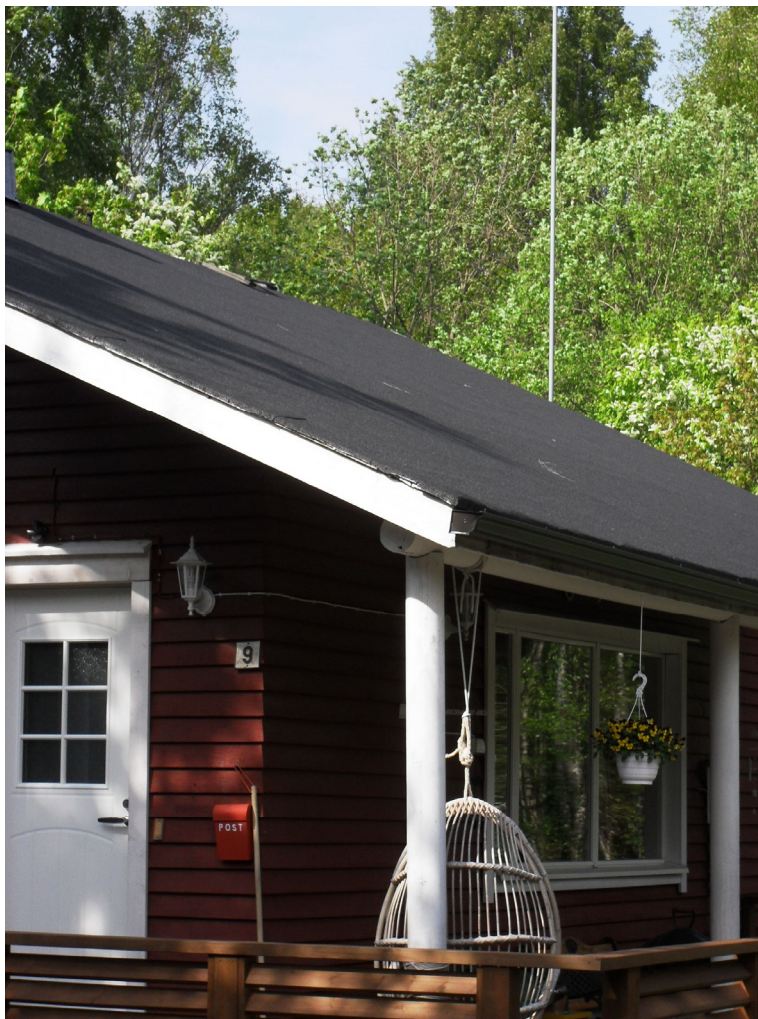
Kuva 16. Suositeltava kattahuovan reunataitos lappeen päätysivussa. Sadevesikourut eivät sen sijaan ole suositeltavia (Hokkanen 2011).
