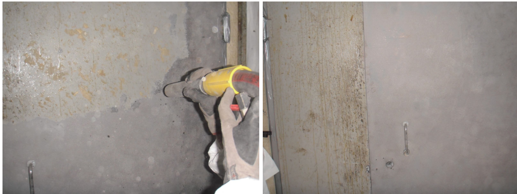
Kuva 21. Vanhaa maalattua metalliovea puhalletaan Sponge-Jet-puhallusmenetelmällä ja kokonaan puhallettu metalliovi
