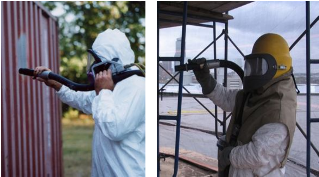
Kuva 6. Kaksi erilaista tapaa suojautua puhalluksen ajaksi (17; 18.)
