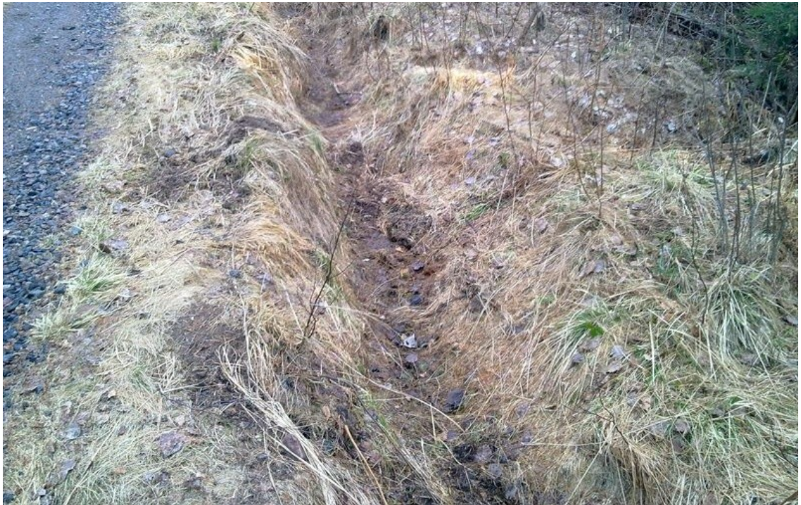
Huonokuntoinen sivuoja, joka oli heinittynyt pahasti ja oli myös tukkeutunut. Näin huonokuntoinen oja tulisi kaivaa auki mahdollisimman pian (Kuva: Janne Kiiskinen 2011)
