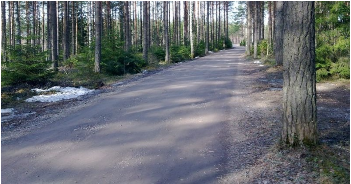
Tällä tiellä sivuojia ei tarvittu, koska maaperä oli vettä hyvin läpäisevää soraa (Kuva: Janne Kiiskinen 2011)
