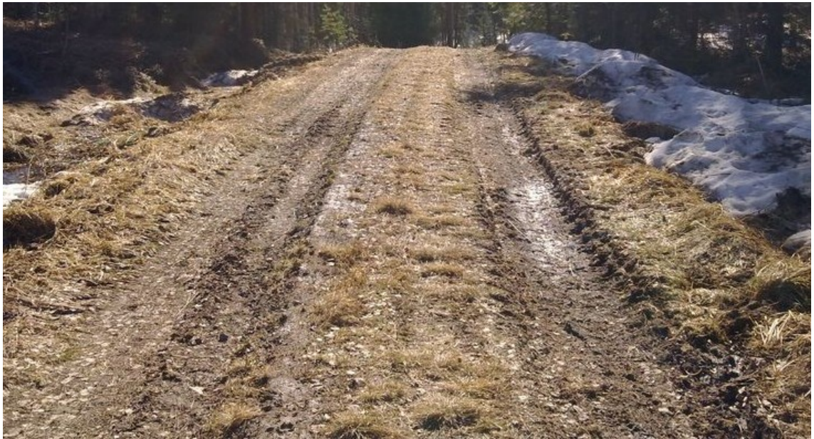
Jo tämän syvyiset raiteet haittaavat henkilöautolla ajoa. Raiteiden keskisyvyys oli arviolta 5 cm (Kuva: Janne Kiiskinen 2011)
