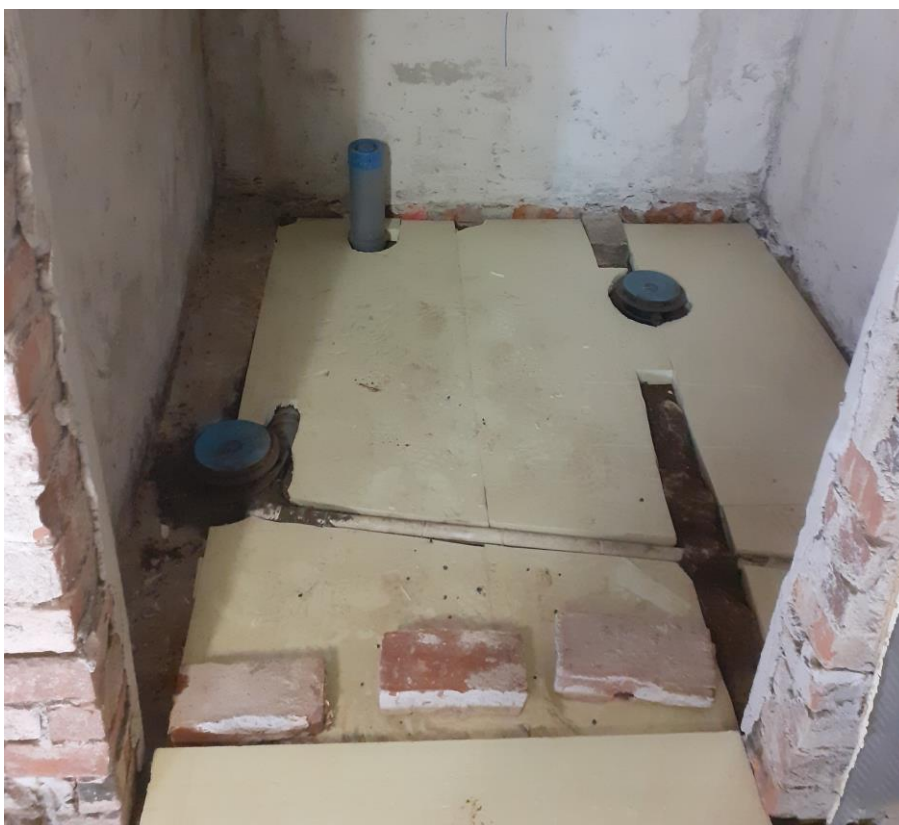
Kuva 11: XPS-levyt asennettu
