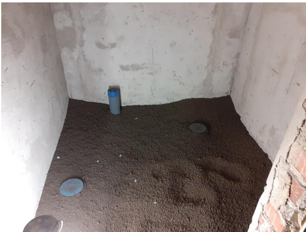
Kuva 10: Leca-sora juuri puhallettuna
