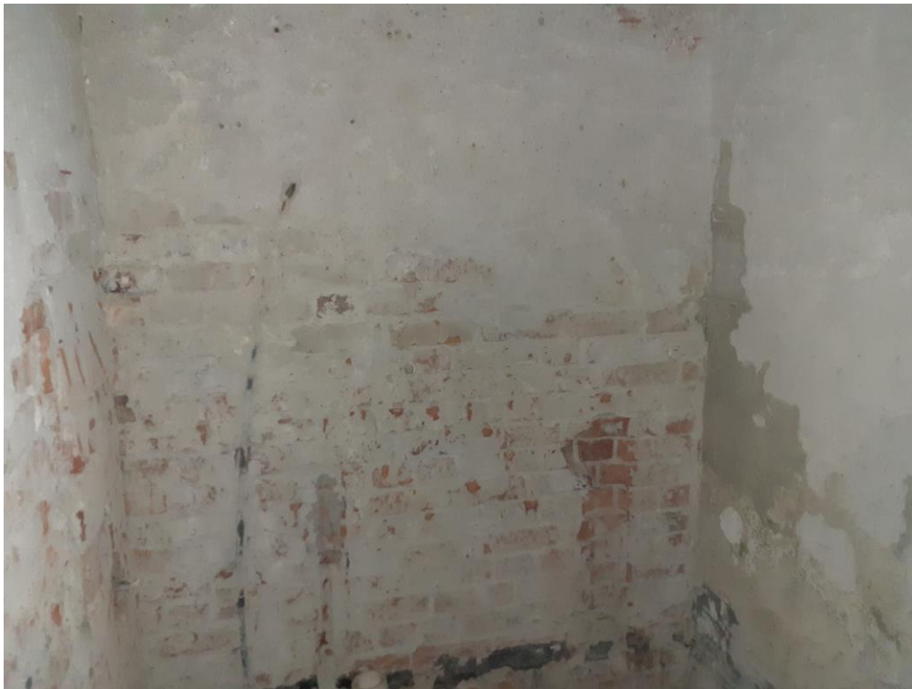
Kuva 2. Poltetuista tiilistä muurattu väliseinärakenne rapatulla pinnalla
