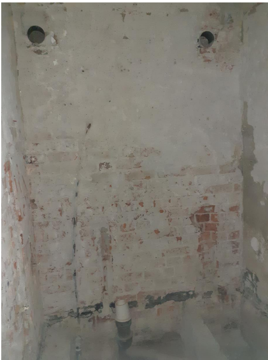
Kuva 6: Rapattu tiiliseinä purkutyön jäljiltä
