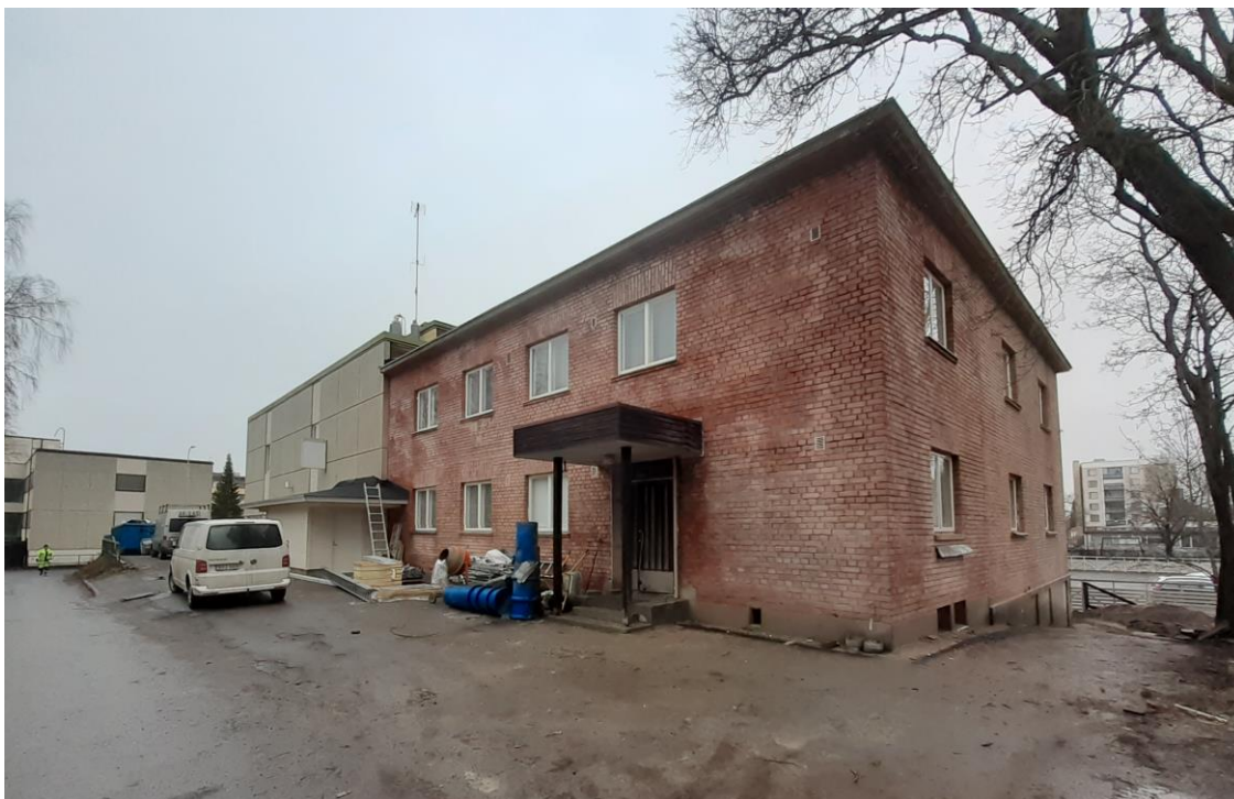
Kuva 5: Kalevantie 9 – julkisivu lounaasta
