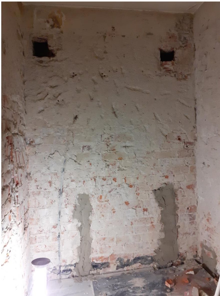
Kuva 7: Seinän osittain täyttö tehty
