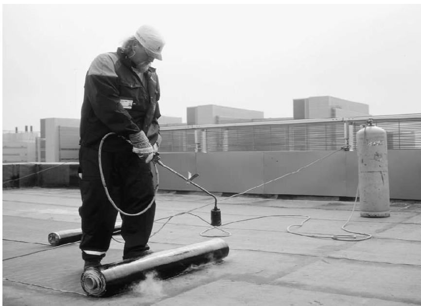
Bild 12 Svetsning av bitumenfilt (RT 85- 10799:10).
