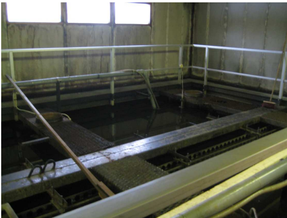
Kuva 6. Jälkiselkeytysaltaat. Valokuva Suvi Niemi 2011
